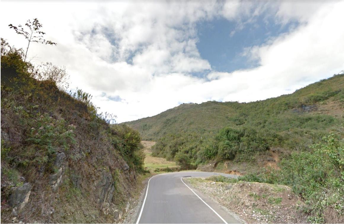
**Figura N° 46** Ancho irregular de calzada.
