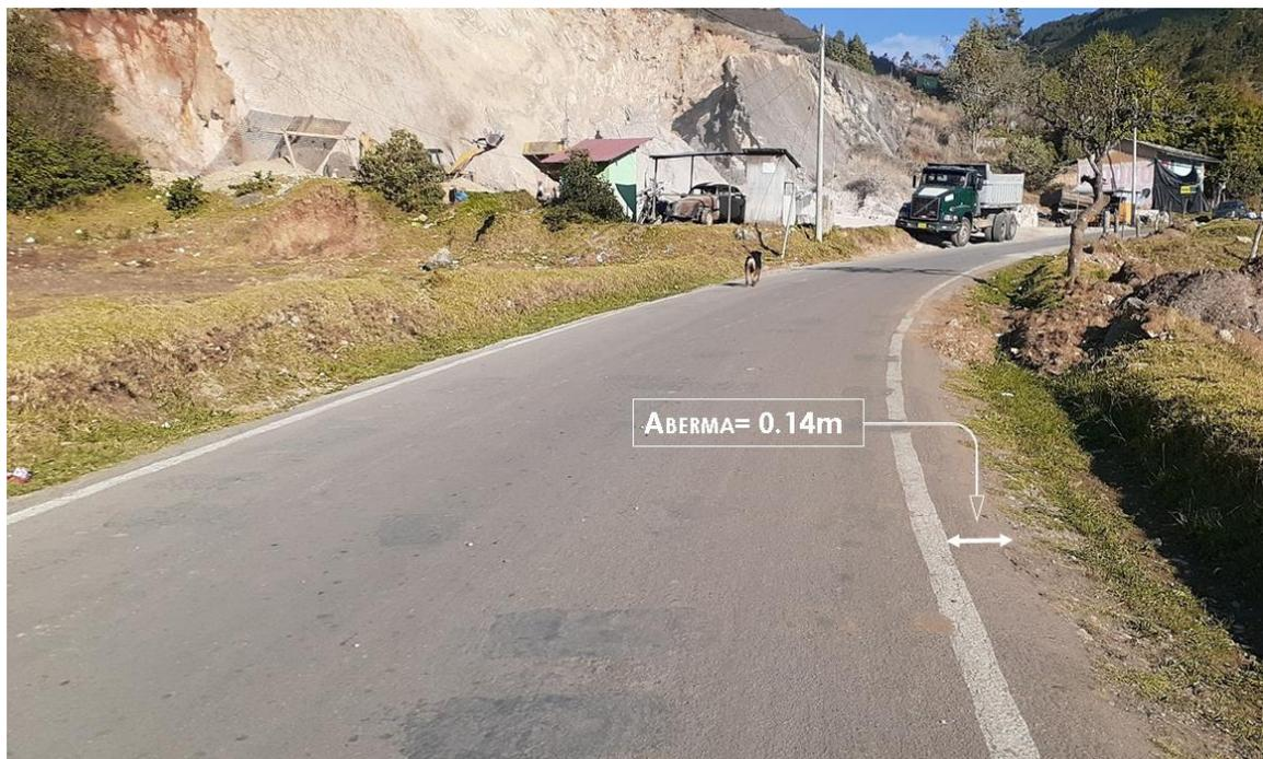
**Figura N° 48** Reducción del ancho de vía en tramo en curva
