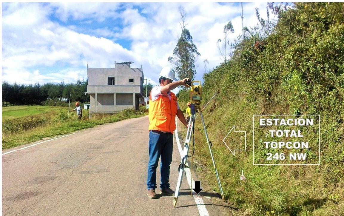
**Figura N° 40** Toma de datos del relieve mediante levantamiento topográfico
