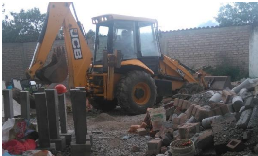
Figura N° 26: Eliminación de desmonte del laboratorio.
