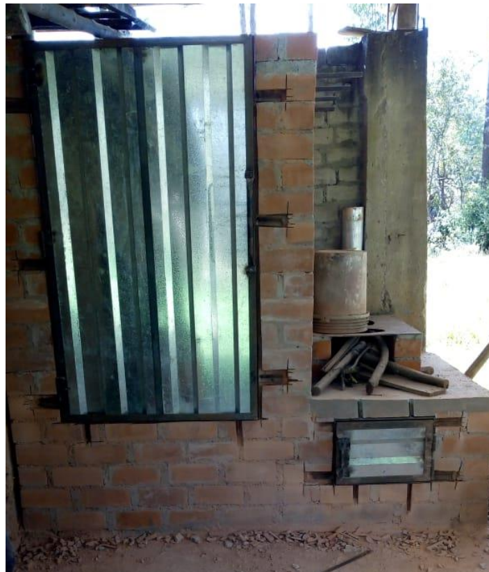
Figura 27. Colocado de puertas en el ahumado.
