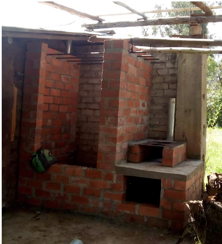
Figura 26. Construcción del ahumador.
