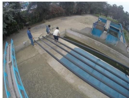
**Imagen 10.** Fotografía izq.) Soldado de los ejes junto a las platinas circulares en los extremos de las tuberías. Fotografía Der.) Distribución de las 5 tuberías en base al ajuste con la faja textil.
