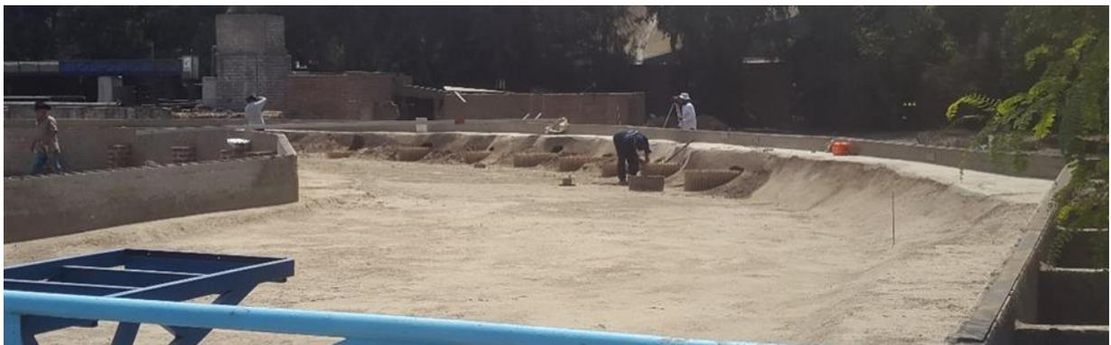
**Imagen 26.** Colocación de los espigones ELJ en el lado cóncavo del canal.
