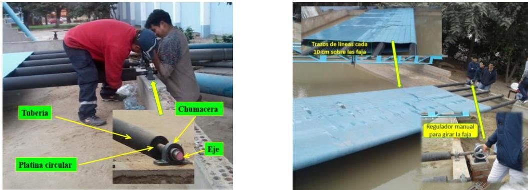
**Imagen 11.** Fotografía izq.) Acoplamiento y empernado de las chumaceras sobre el muro izquierdo del canal. Fotografía Der.) Regulador manual para adecuarse al caudal de troncos, y trazado de líneas para las subáreas.
