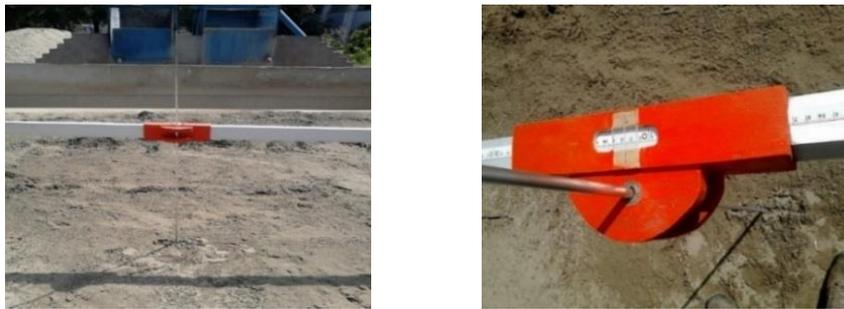
**Imagen 16.** Regla, carro deslizante y varilla metálica vertical.
