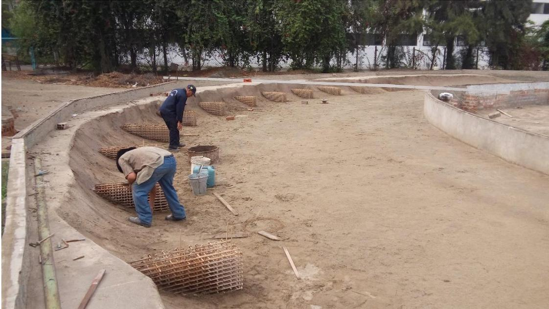
Colocacion de los espigones ELJ en el lado sometido a socavación.
