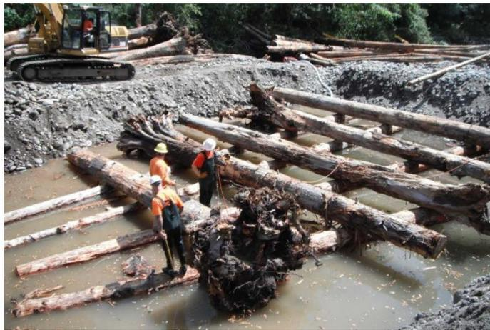
**Imagen 6.** Construcción de un espigón ELJ que está siendo instalada en el río del salmón (fotografía de Knutson y Fealko, 2014).
