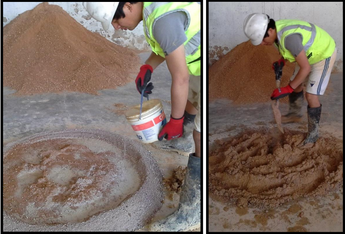
Figura N°54: Agregado de agua y amasado de la mezcla.
