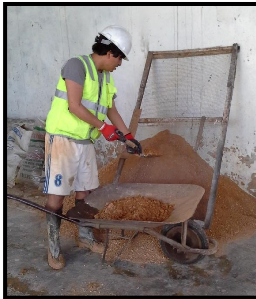
Figura N°37: Tamizado de la tierra, separando las piedras de tamaño mayor a 5mm y agentes extraños.
