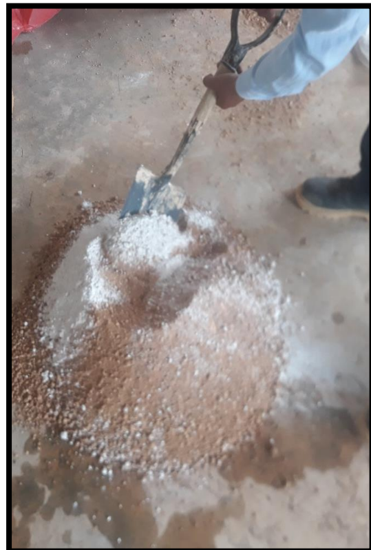
Figura N°53: Combinación de la cal con el suelo.
