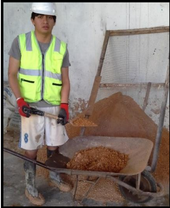
Figura N°46: Tamizado de la tierra separando las piedras de tamaño mayor a 5mm y agentes extraños.
