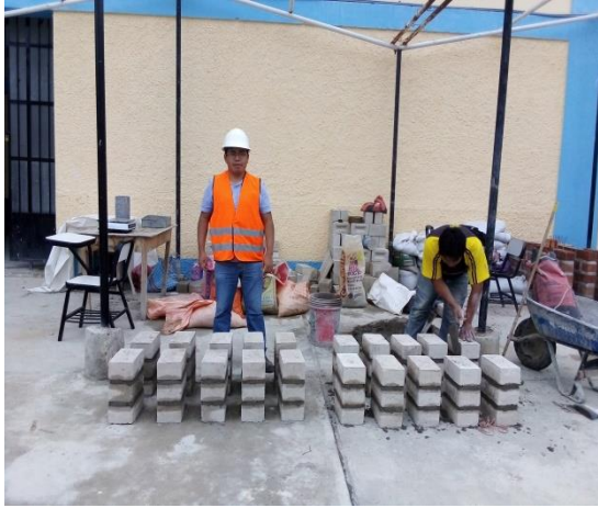
Figura 35. Pilas con unidades de concreto de las ladrilleras Aguilar y Lezama.
