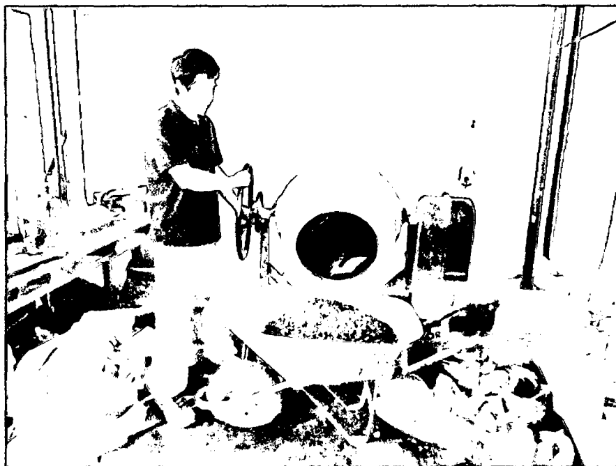
Foto 14: Elaboración de las tandas de concreto.
