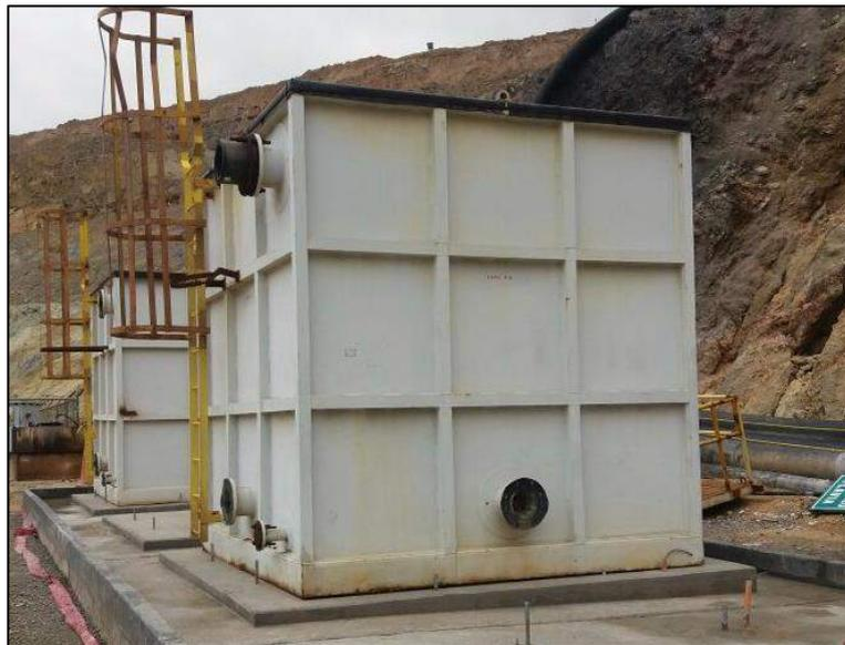
Figura 39. Tanques de rebombeo. Visitada el 23/05/2018
