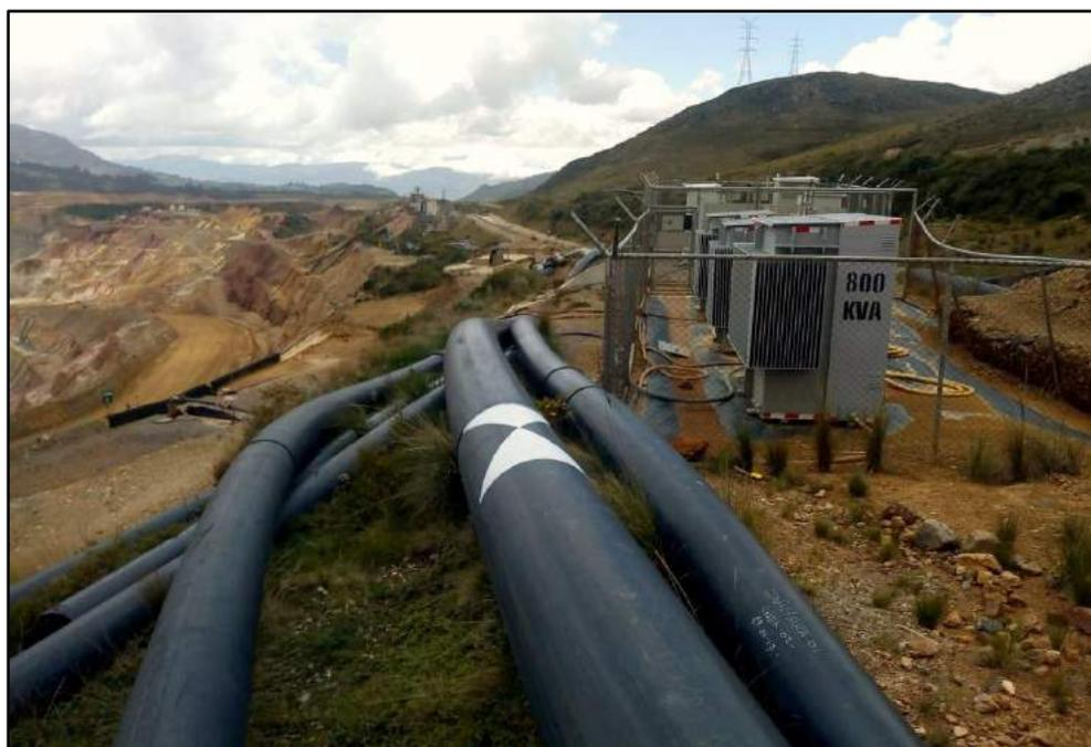
Figura 20. Tuberías de HDPE – tajo “Tapado Oeste”. Visitada el 6/12/2018.
