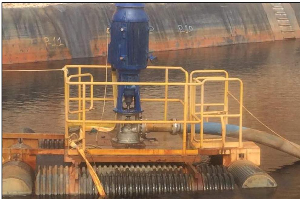
Figura 16. Balsa tipo flotante con bomba turbina vertical. Visitada el 6/12/2018.
