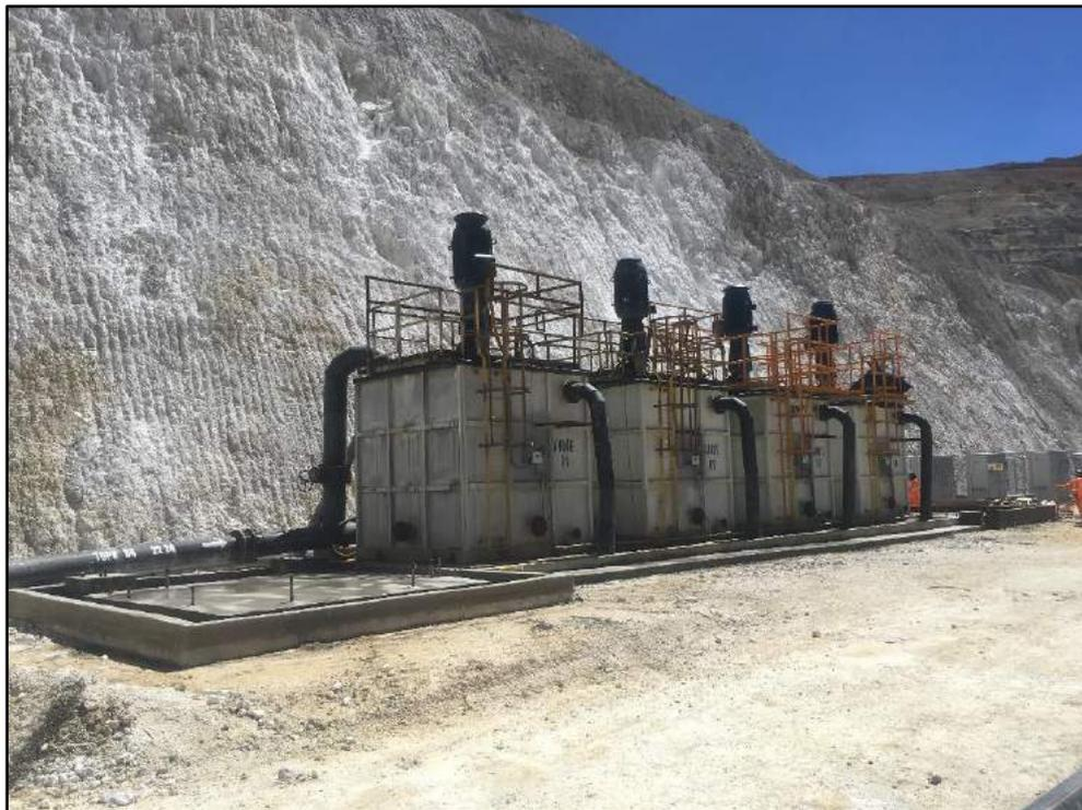
Figura 5. Sistema de tanques de rebombeo – tajo “El Tapado”. Visitada el 6/12/2018
