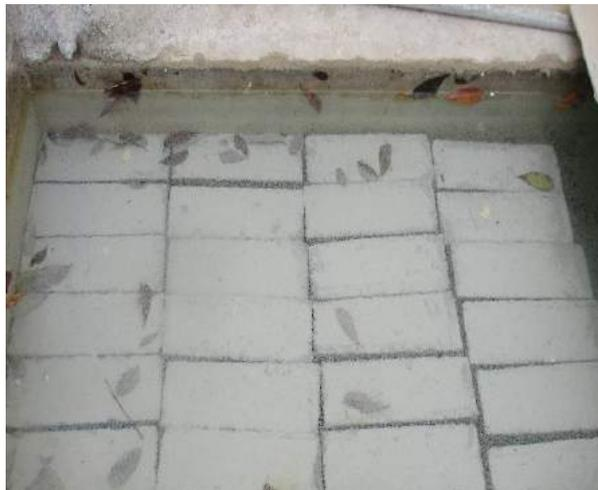
**Figura 21:** Alabeo de ladrillos de concreto
