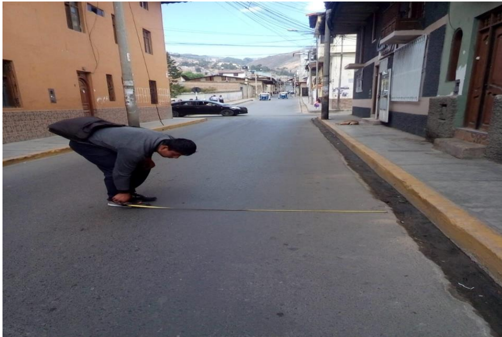
Foto 12: Medida del ancho de la calzada en el Jr. Miguel Iglesias, tramo I.
