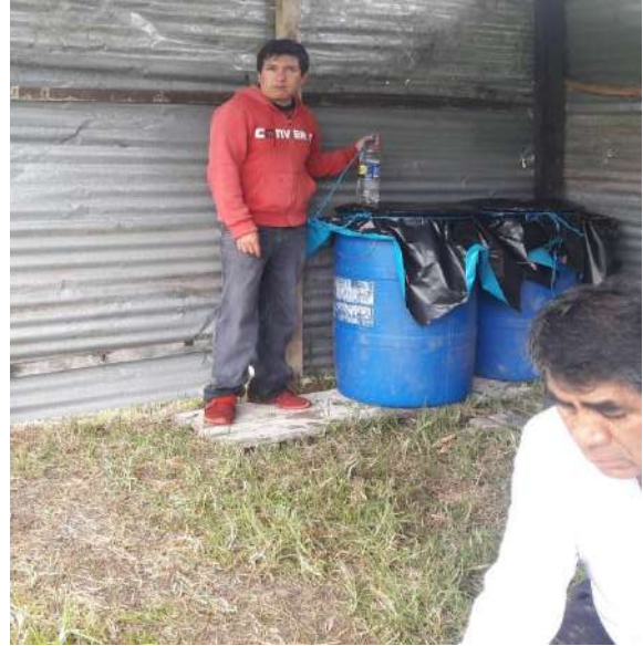
Fotos 2. Biodigestores caseros
