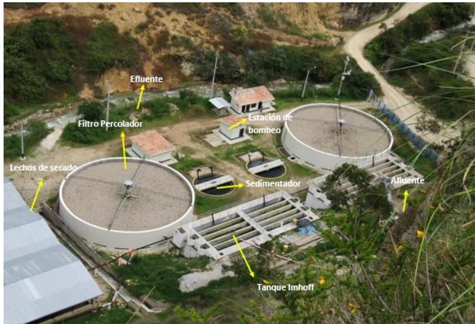
**Figura 13.** Distribución de la Planta de Tratamiento de Agua Residuales de la localidad de Cajabamba (PTAR)
