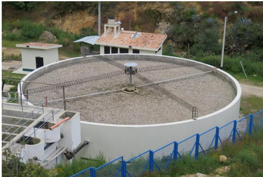
**Figura 14.** Filtro percolador de la PTAR Cajabamba
