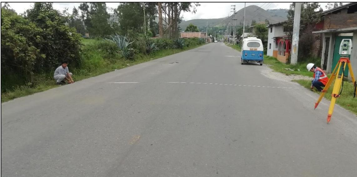
**FOTOGRAFÍA N°06:** Medición de ancho de Calzada en tramos rectos.
