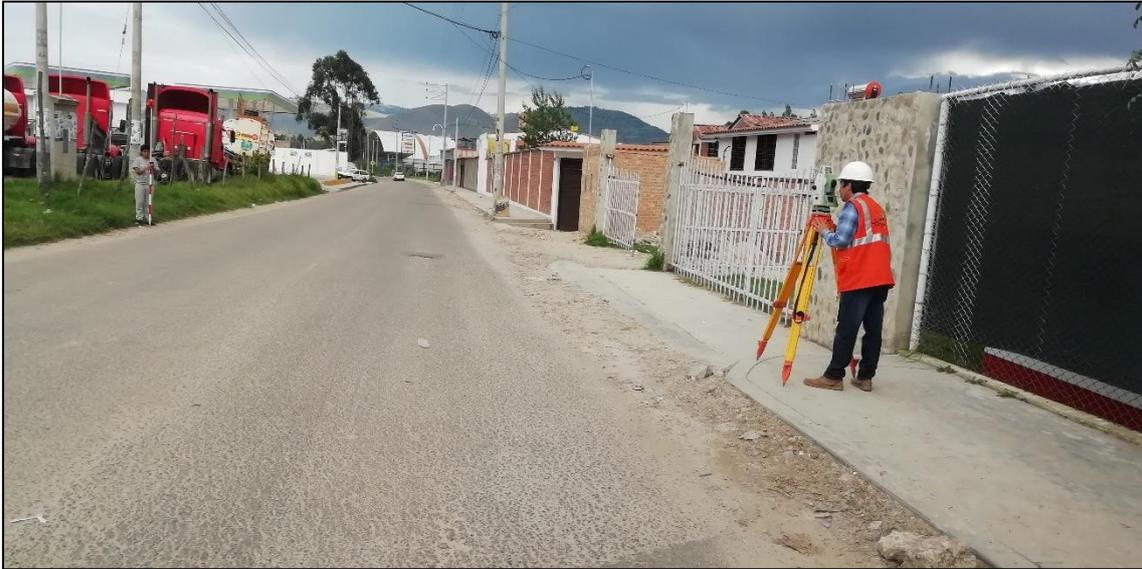
**FOTOGRAFÍA N°03:** Levantamiento Topográfico del ancho de calzada.
