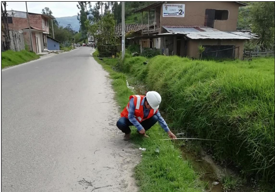
**FOTOGRAFÍA N°08:** Medición de ancho de cunetas.
