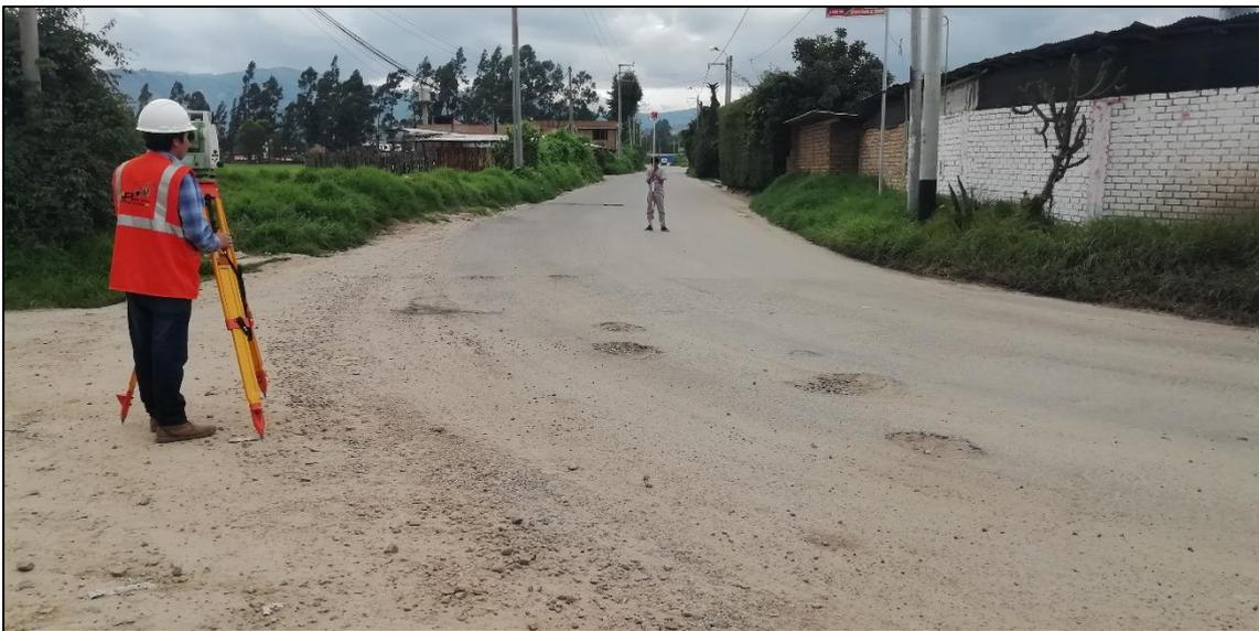
**FOTOGRAFÍA N°04:** Levantamiento Topográfico en curva horizontal C5.
