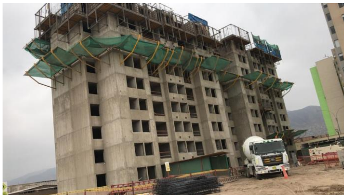
Figura II.5: Encofrado FORSA PLUS y SISTEMA TREPANTE
