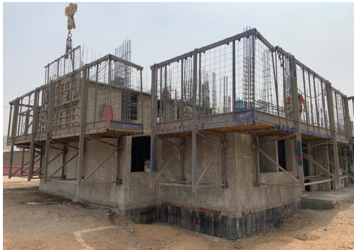
Figura II.4: Colocación de acero en muros
