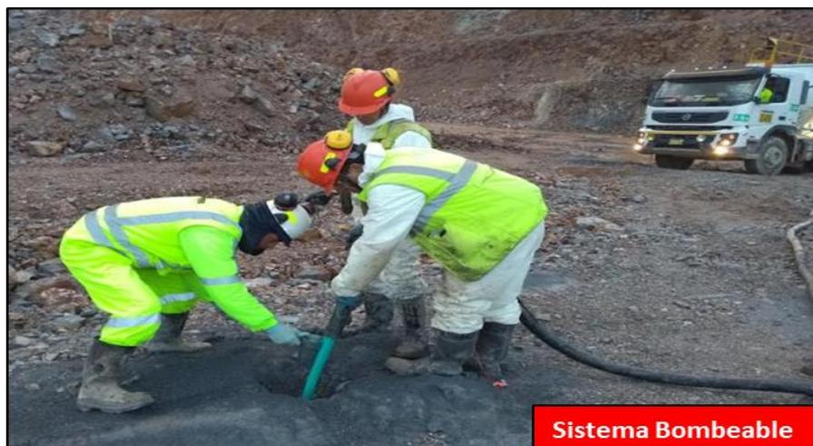
Figura N°15: Personal de campo cargando taladro y tomando muestra para verificación de densidad.
