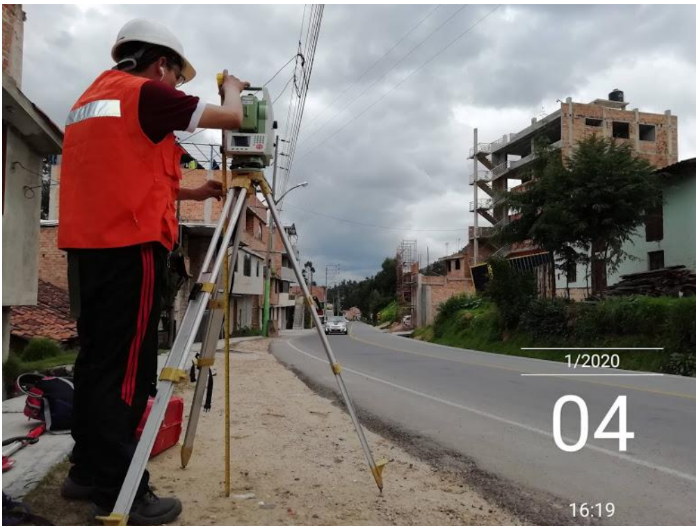
Fotografía N° 10: Estación en un tramo en curva de la carretera
