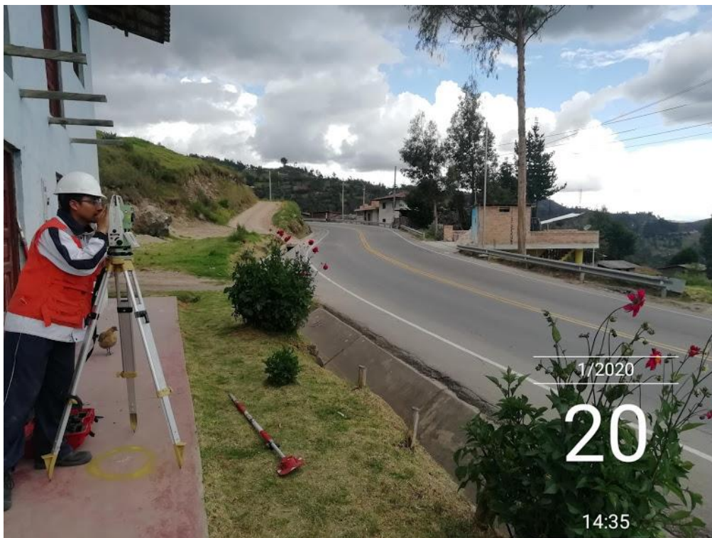
Fotografía N° 19: Último día que se realizó el levantamiento
