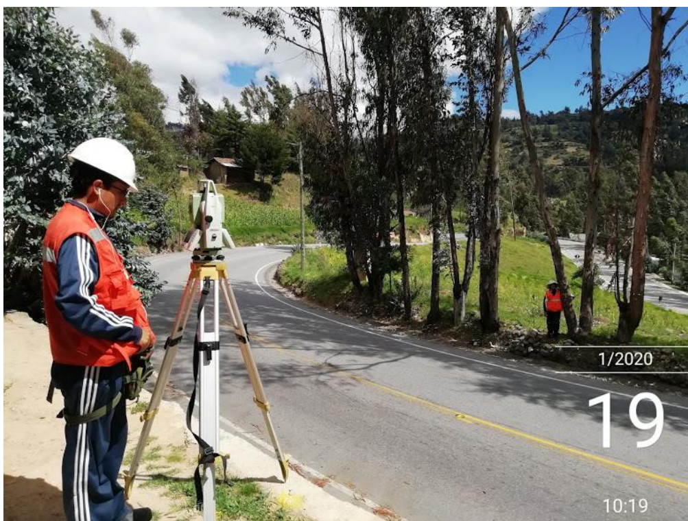
Fotografía N° 16: Estación en un tramo curvo el quinto día de levantamiento
