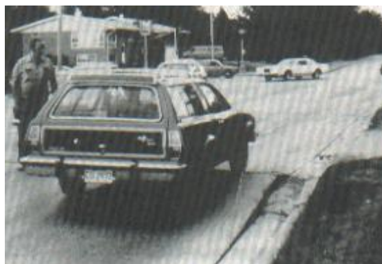
Figura 5: Blowup / Buckling de alta severidad.
