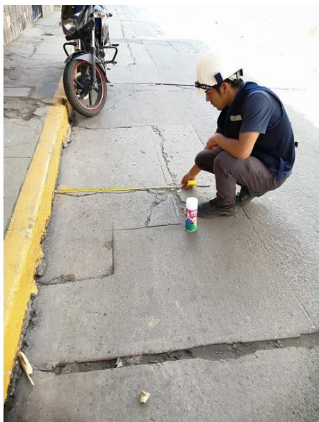
Foto N° 37: Se puede apreciar la falla de parcheo pequeño de severidad leve (L) y media (M)
