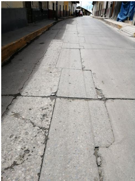
Foto N° 15: Parcheo grande y pequeño de severidad leve (L) y media (M)
