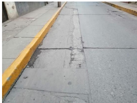
Foto N° 43: Se están tomando datos de grietas lineales de severidad media (M)
