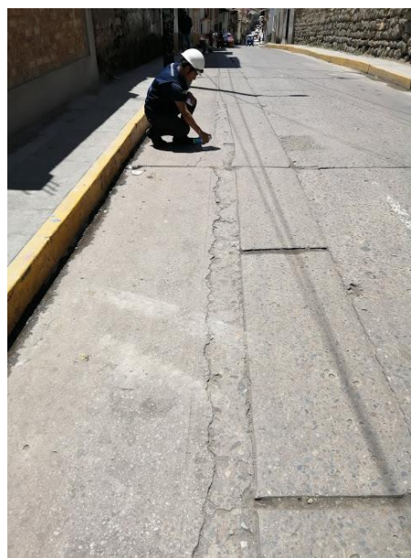
Foto N° 07: Toma de datos de grietas lineales de severidad alta (H).
