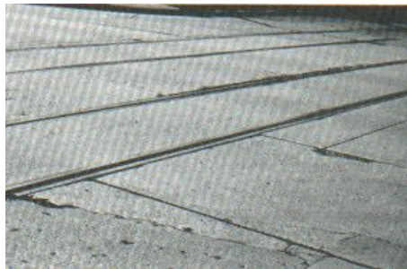
Figura 39: Cruce de vía férrea de baja severidad.
