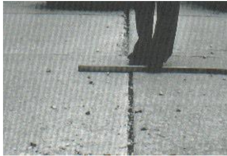
Figura 15: Escala de baja severidad.
