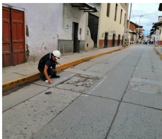
Foto N° 51: Se está delimitando el tipo de falla Losa dividida de severidad alta
