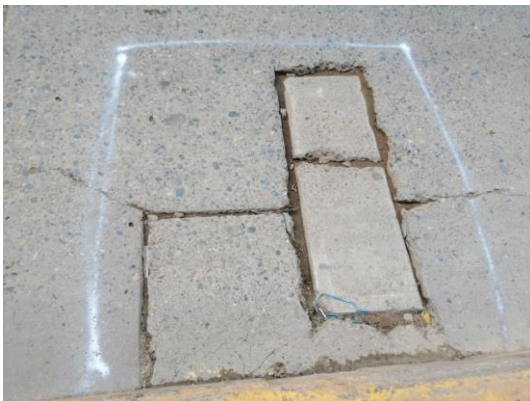
Foto N° 55: En la fotografía podemos observar un parcheo pequeño de severidad media
