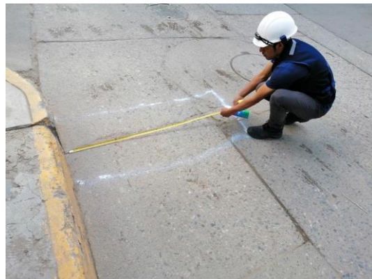
Foto N° 55: En la fotografía podemos observar un parcheo pequeño de severidad media
