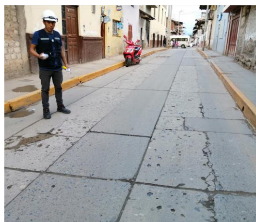
Foto N° 51: Se está delimitando el tipo de falla Losa dividida de severidad alta
