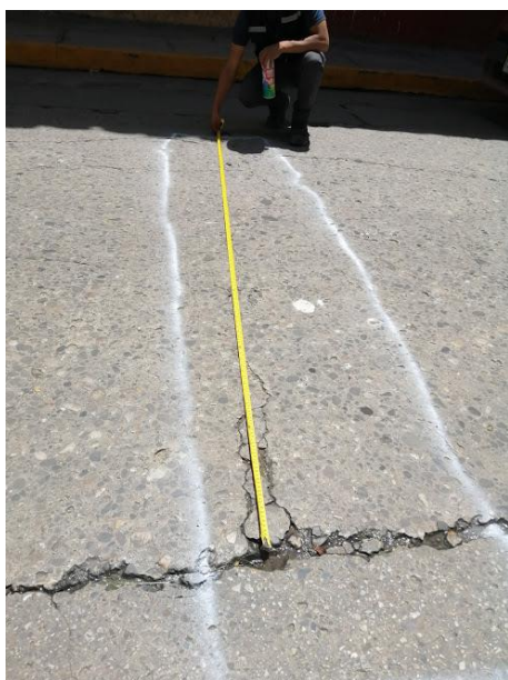
Foto N° 07: Toma de datos de grietas lineales de severidad alta (H).
