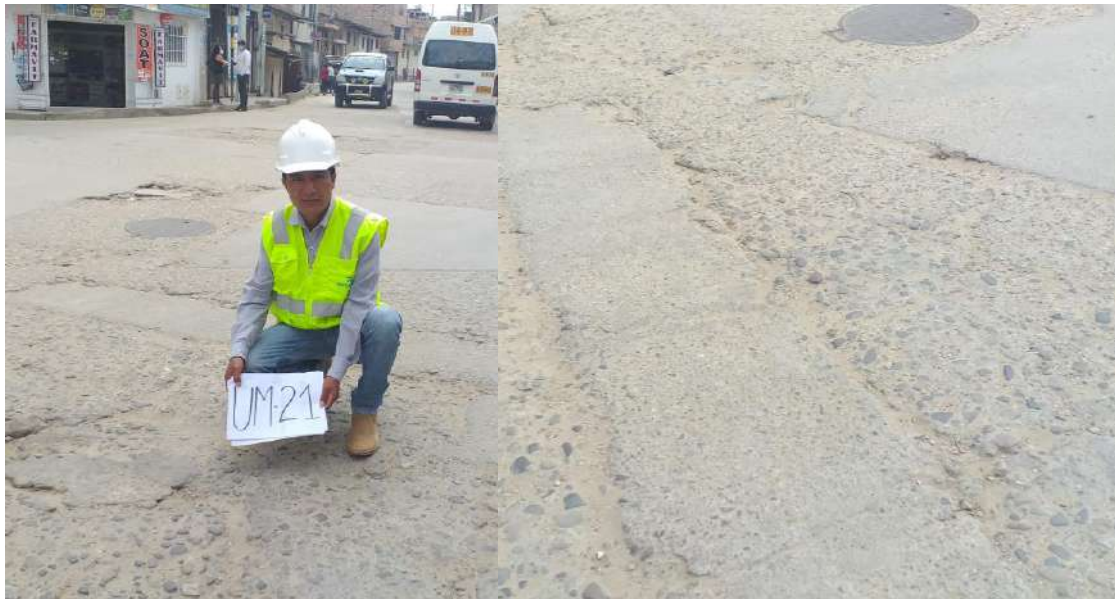
Fallas: Losa dividida y parche grande.
