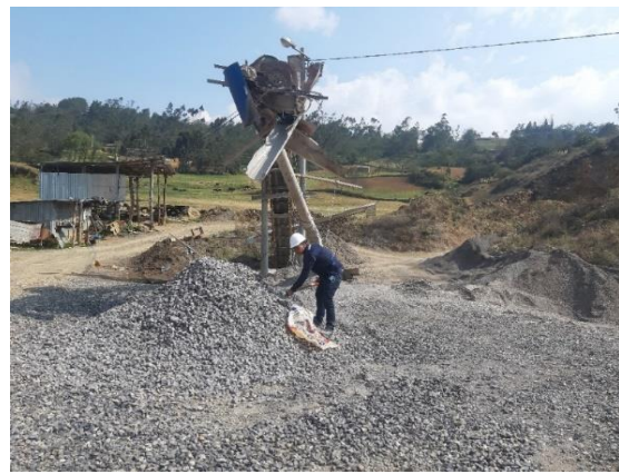
Fotografía N°02: Extracción de agregado grueso en la cantera “LANCHECONGA”
