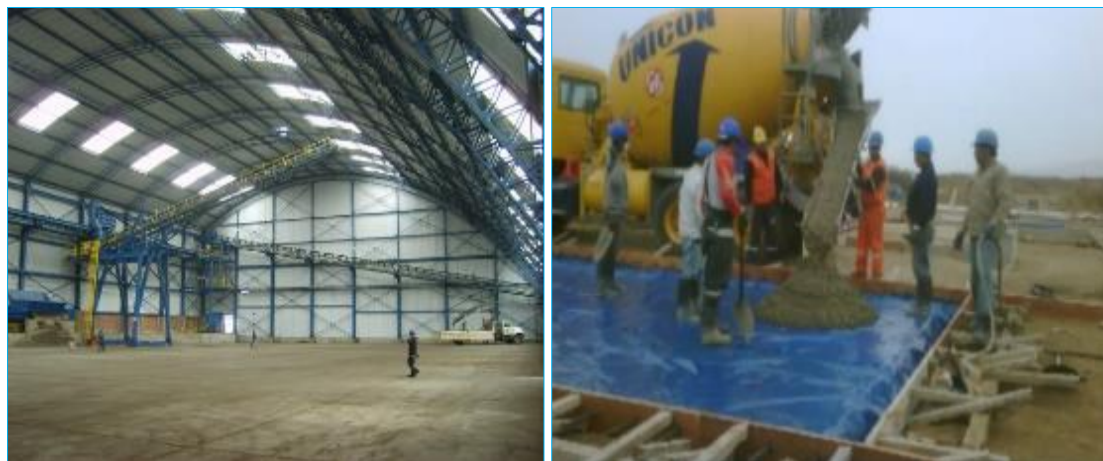
Figura 49– construcción de planta metalmecánica IMECON (fuente: Imecon)
