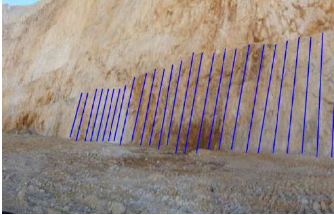
Figura 22: Taladro de pre corte. (Yanacocha, 2015)
