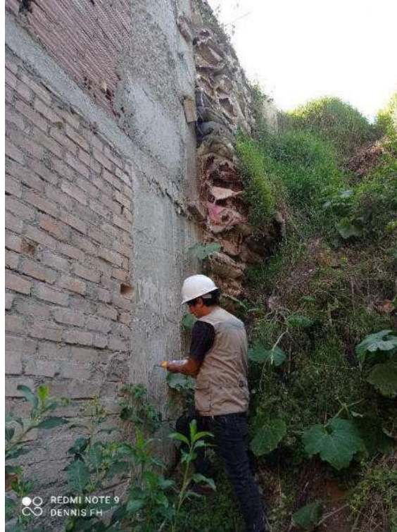
Foto N° 05: Ubicación del Ensayo estándar en placa rebote en concreto endurecido.
