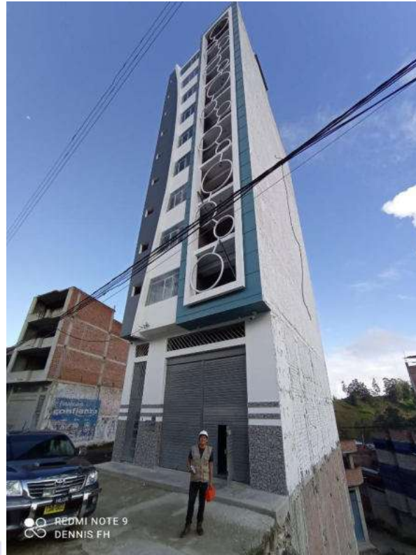
Foto N° 01: Vista de la edificación en Av. Tacabamba.
