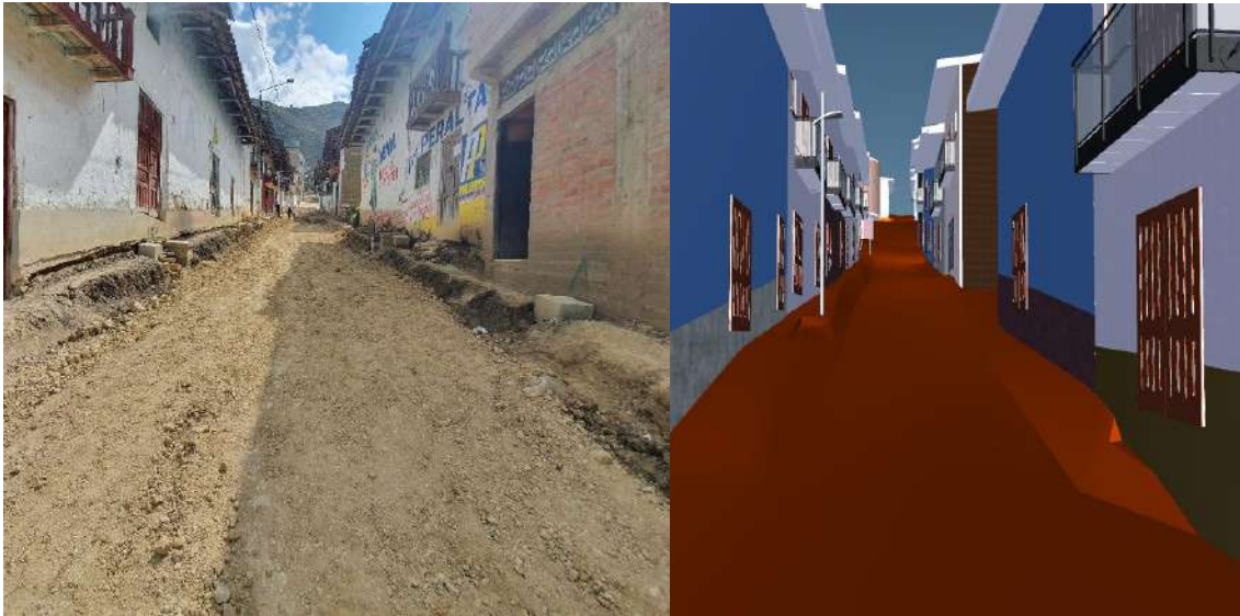
Figura N° 26: En esta vista se muestra el Jr. Comercio, comparando la situación antes de la ejecución del proyecto y el modelado BIM. Fuente: Naviswork (2021)
