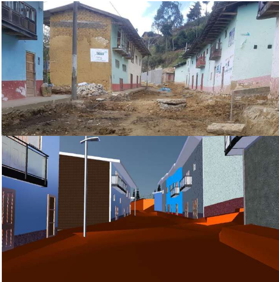
Figura N° 24: En esta vista se muestra el Jr. Jaén, comparando la situación antes de la ejecución del proyecto y el modelado BIM. Fuente: Naviswork (2021)
