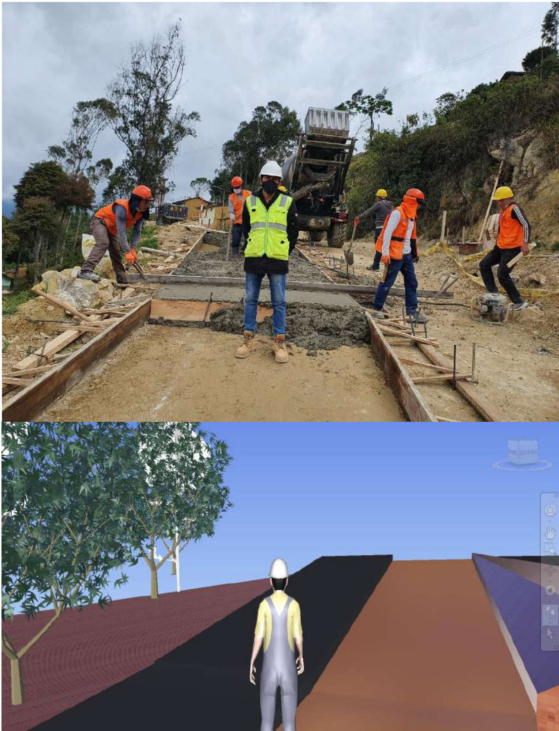
Figura N° 48: Culminación pavimento rígido de concreto f'c=210 \text{ kg/cm}^2 y veredas de concreto f'c=175 \text{ kg/cm}^2 del área urbana, control de avance realizado con metodología BIM.
