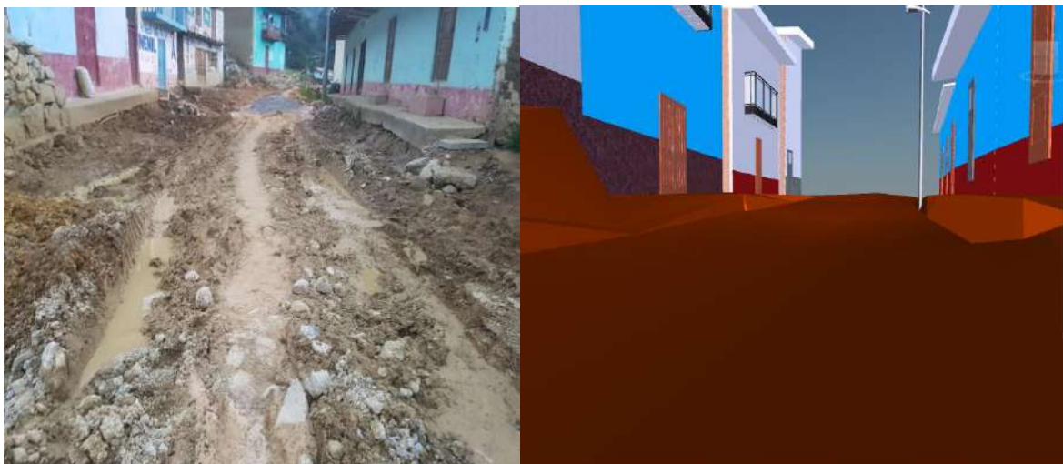
Figura N° 23: Se observa el Jr. Santa Rosa, en el margen izquierdo el área de trabajo antes de la ejecución del proyecto y al margen derecho el modelado BIM. Fuente: Naviswork (2021)
