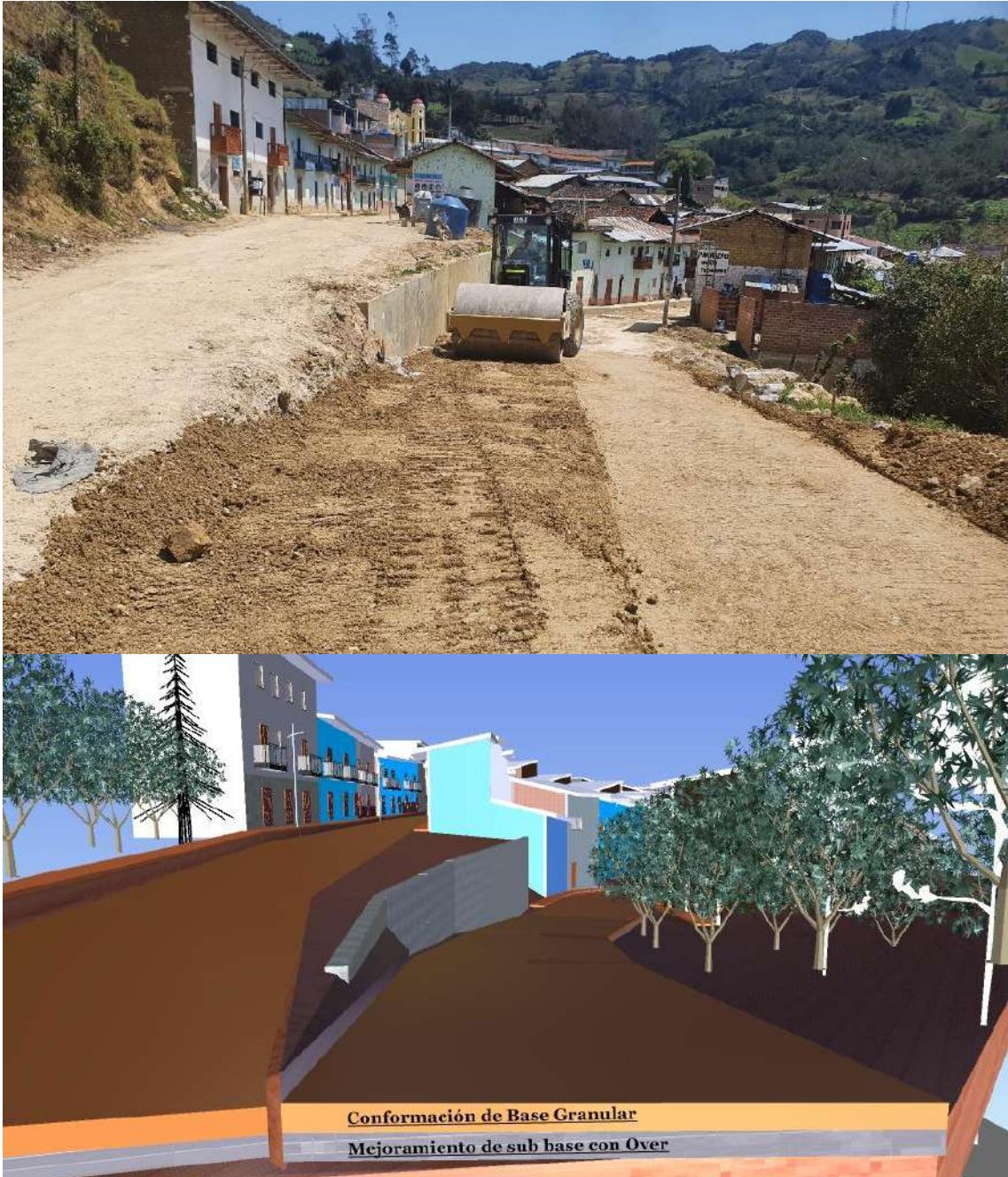
Figura N° 46: Conformación y compactación de base granular, control de avance realizado con metodología BIM. Fuente: Elaboración propia
