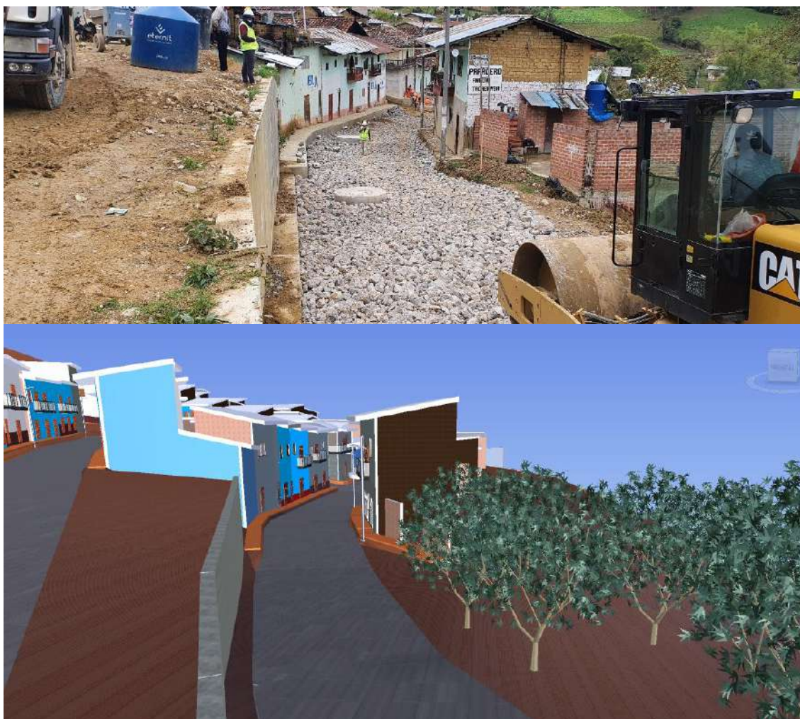
Figura N° 45: Mejoramiento de subrasante, control de avance realizado con metodología BIM.
