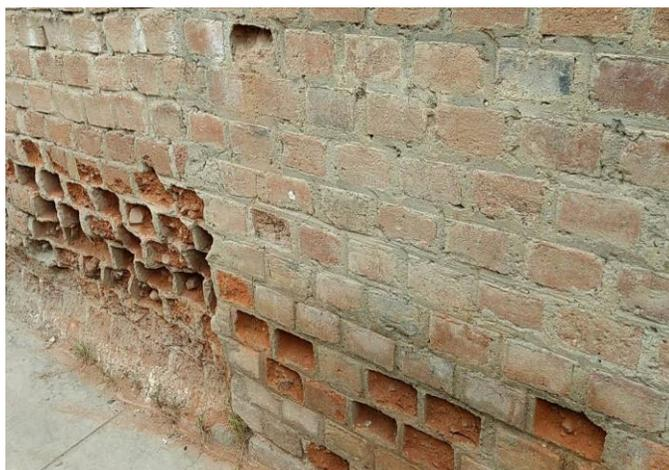
erosión de juntas probocadas por las constantes inundaciones
