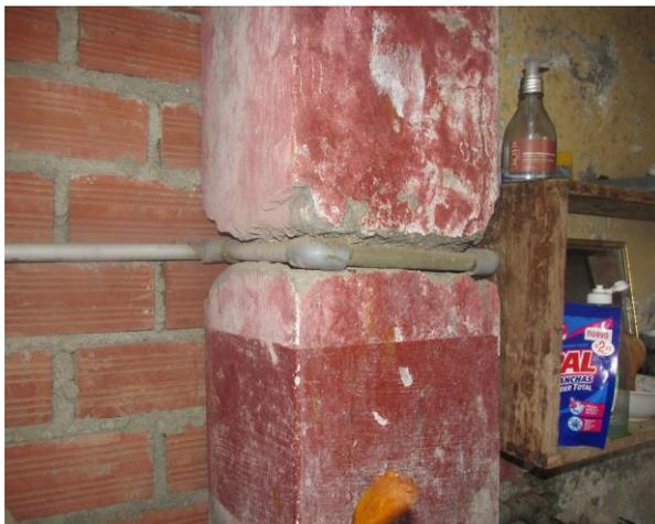
deterioro agresivo de las columnas para instalación de agua
