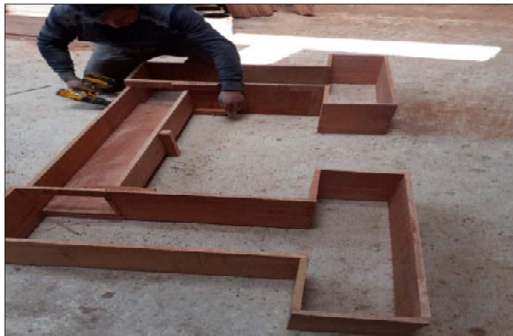
Figura 3.5. Encofrado de madera tornillo para pórtico de concreto armado.
