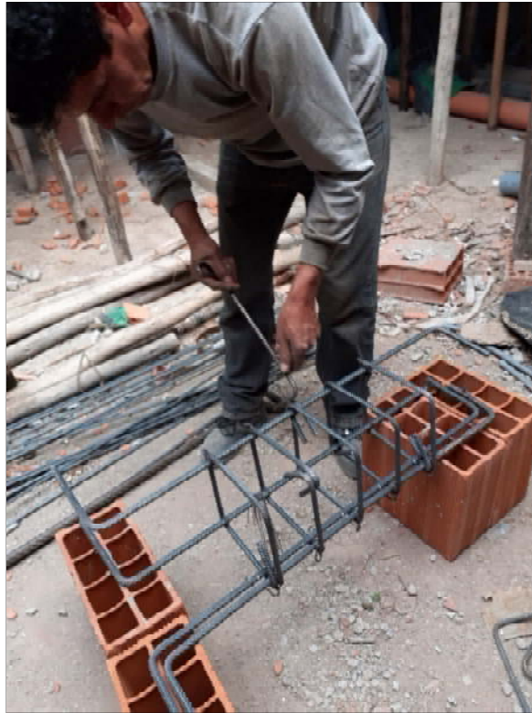
Fotografía N°9. Preparación de Pórticos Pre-Ensayo en la Maquina Universal de 100 ton del Laboratorio de Ensayo de Materiales de la Universidad Nacional de Cajamarca.
