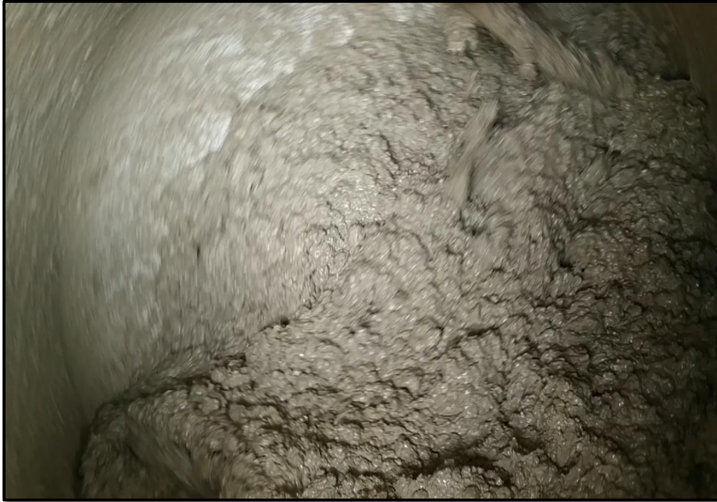
Fotografía 17: Aspecto de la mezcla de concreto antes de añadir el aditivo anti-deslave
