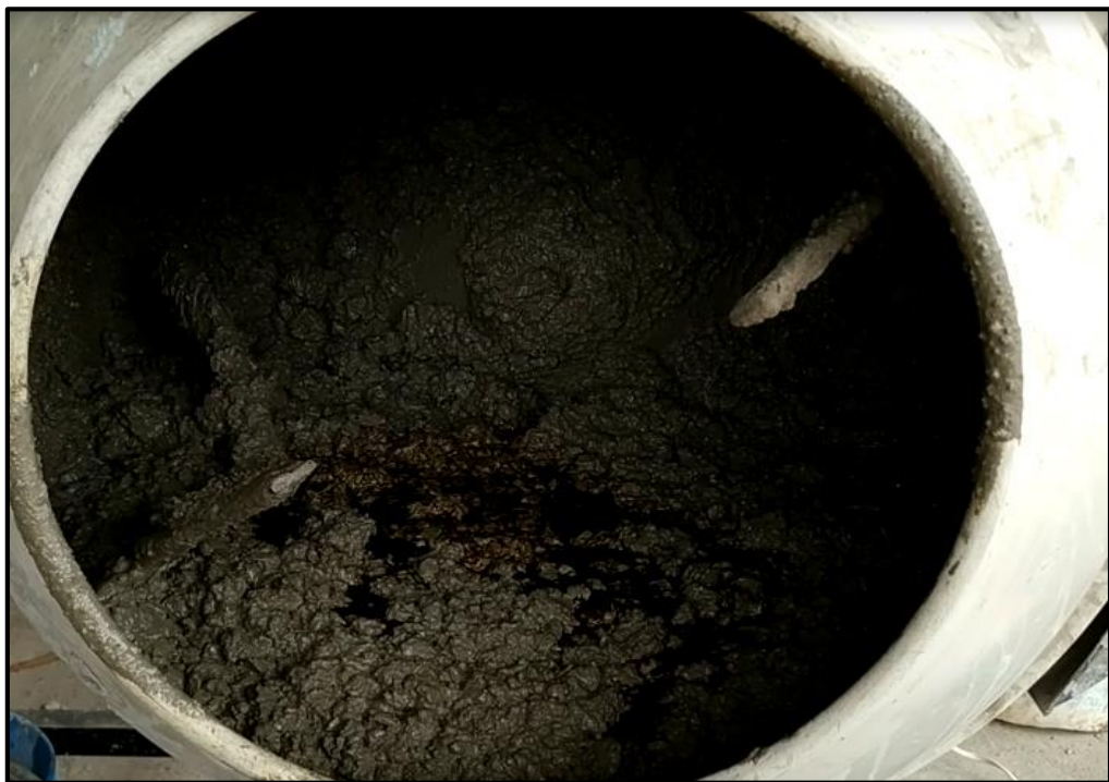
Fotografía 20: Adición de aditivo plastificante para recuperar la trabajabilidad
