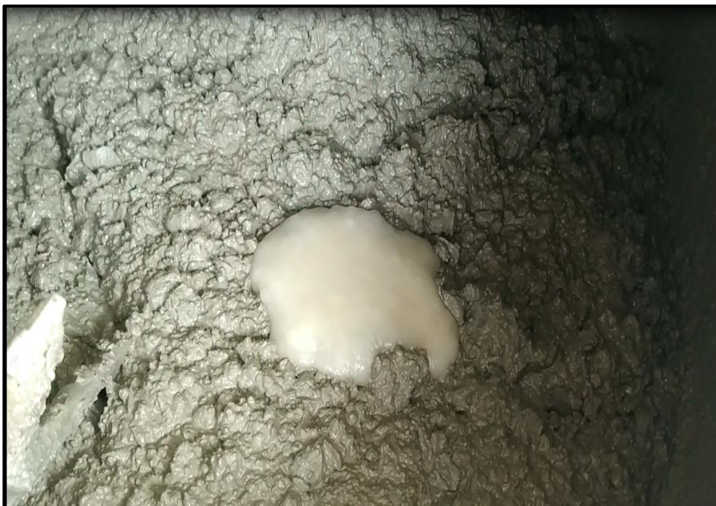
Fotografía 18: Adición a la mezcla al añadir el aditivo anti-deslave
