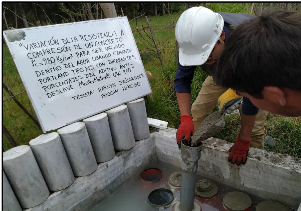
Fotografía 22: Colocación del concreto por el método tremie
