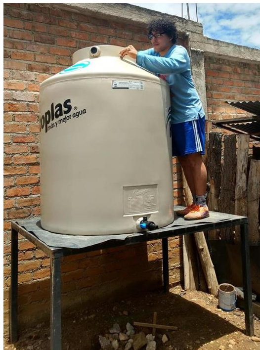
Figura 6: Colocación del tanque de polietileno sobre la estructura metálica
