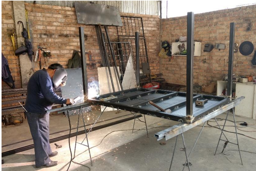
Figura 5: Construcción de la estructura metálica
