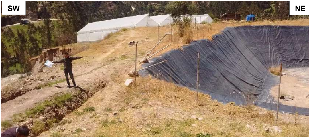
Foto 21. Se puede apreciar el reservorio construido con la finalidad de almacenar agua para su agricultura y ganadería.
