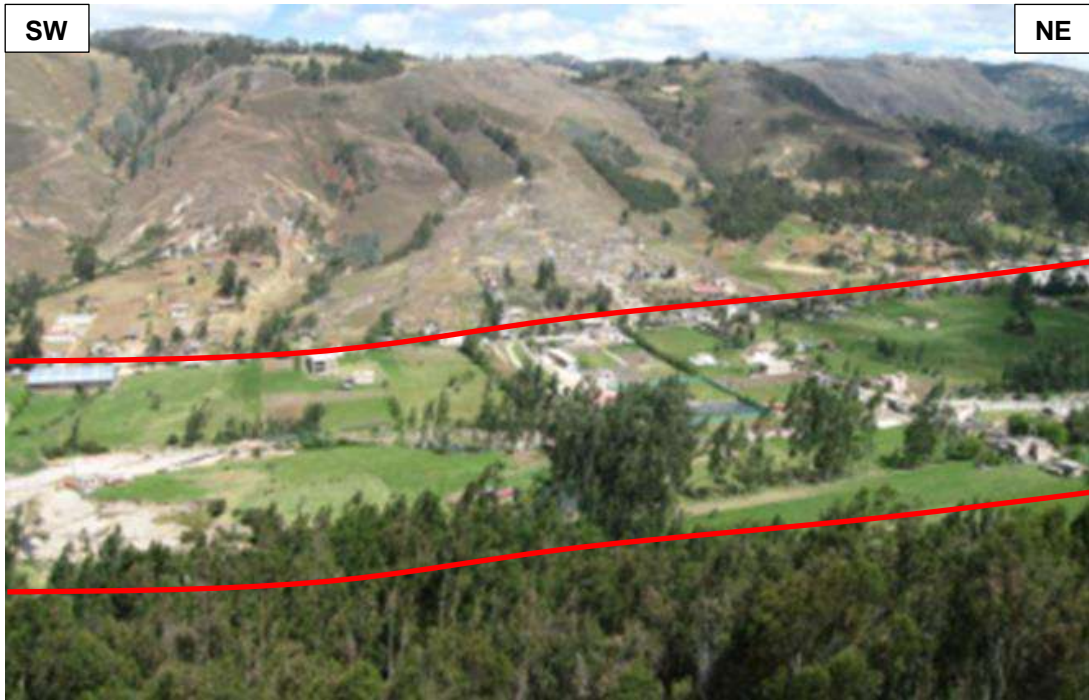
Foto 10. Valle ubicado al Noreste de Huambocancha entre le Río Porcón y el Río Grande, que está conformado por tobas dacíticas del Volcánico San Pablo.
