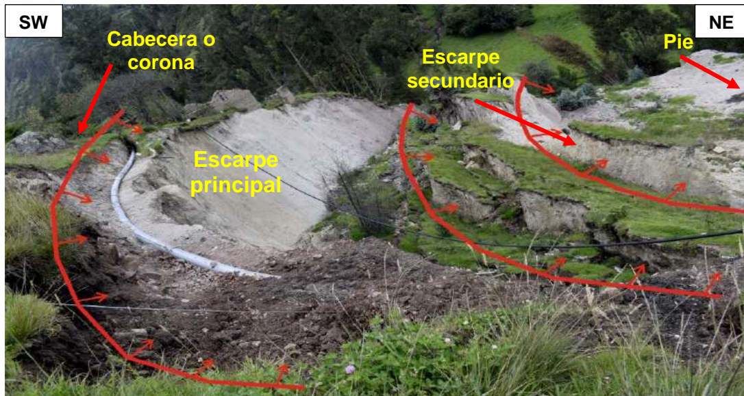
Foto 19. Deslizamiento provocado por la inestabilidad del talud debido a la falta de cobertura vegetal, alta saturación de agua, ausencia de drenajes definidos, su abrupta pendiente y su baja cohesión de los materiales porosos de las rocas volcánicas.
