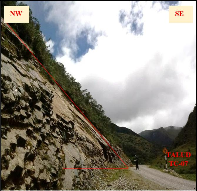
Foto 3.26 Talud TC-07 calizas limo arcillosas de la formación Aramachay (Ji-a) en las progresivas 20+208– 20 +218.5
