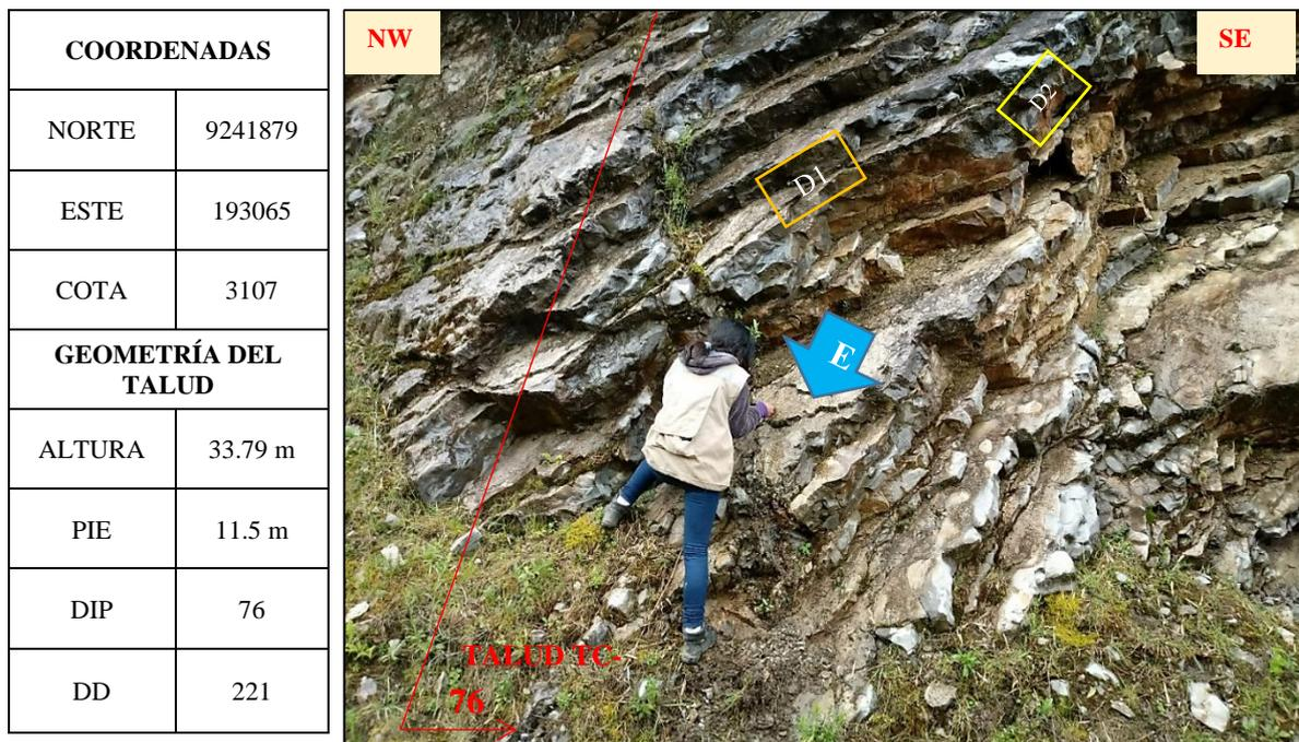
Foto 3.25 Talud TC-06 calizas de la formación Chambará (Tr-Ch) en las progresivas 16+658 – 16 +664
