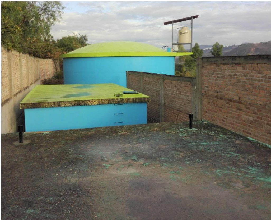
FOTO N° 03: Vista de los reservorios de concreto armado.
