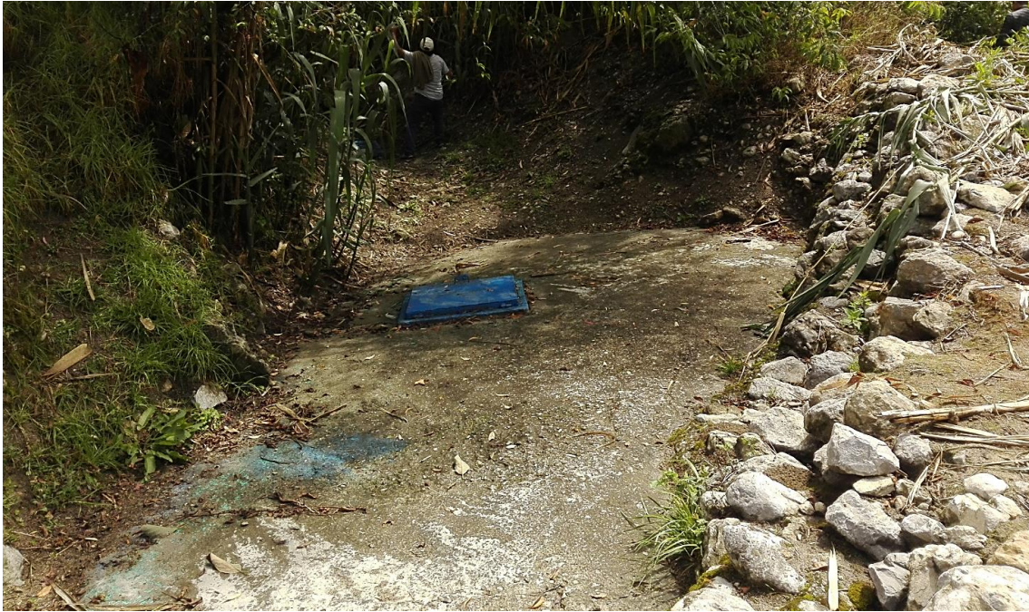
Foto N° 02: Vista de captación y vista de la cámara húmeda
