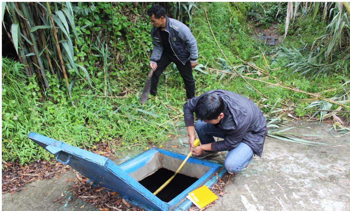
Foto N° 10: Verificando el estado y las dimensiones de la captación “La Huanga Negra”
