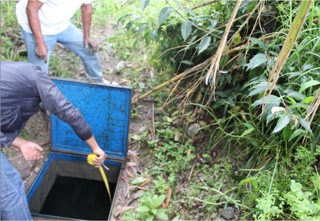
Foto N° 12: Tomando el dimensionamiento de la cámara húmeda de la captación.
