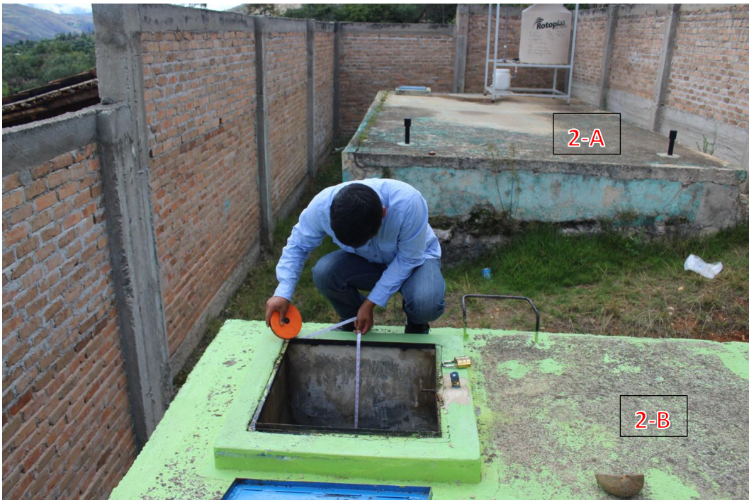
Foto 17: Reservorios rectangulares (2-A) y (2-B) que abastecen al Sector 2
