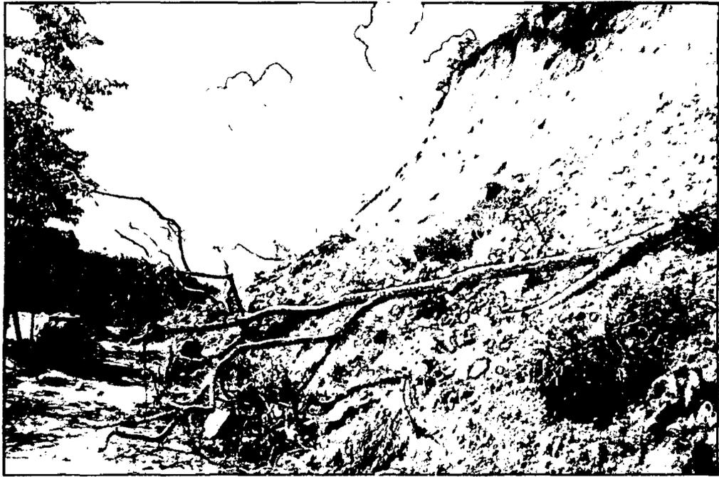
Figura 05. Progresivas 14+900 – 14+920. Lado Derecho – Deslizamiento Superficial.
