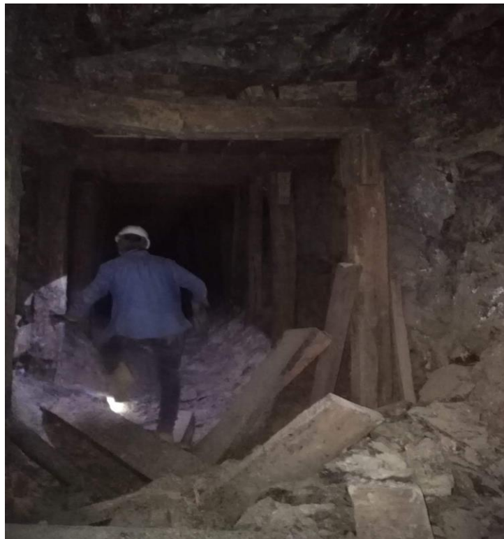
Foto 4.3 Nivel N° 05, Labor que necesita sostenimiento.
