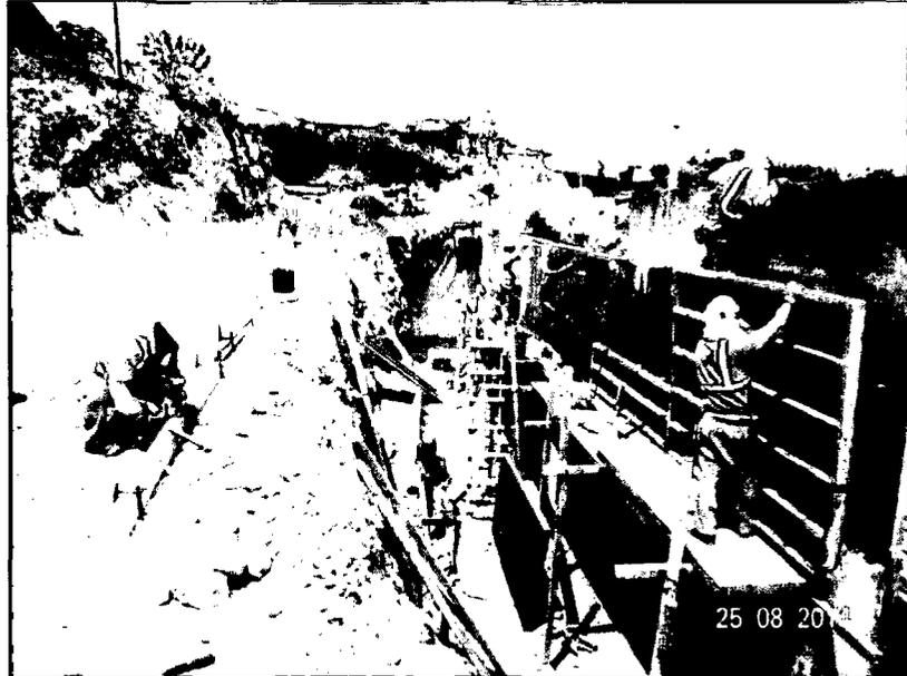
Figura 15: Encofrado y solaqueado de la pantalla
