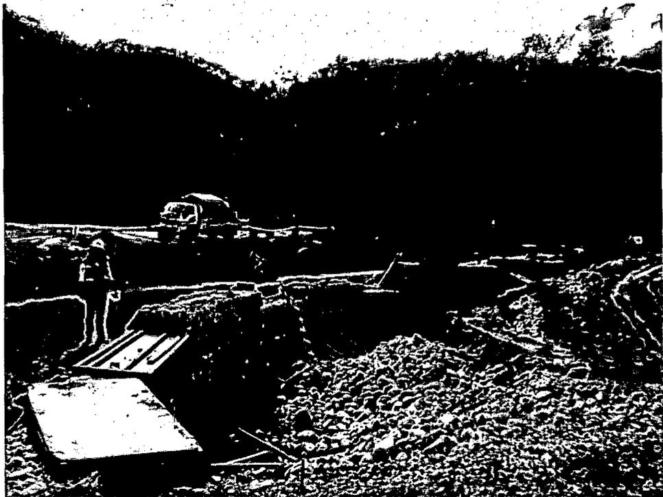
Figura 37: Ejecución del muro de suelo reforzado (terramesh) ubicado en el Km. 17+539,00 al Km.17+693,00.
