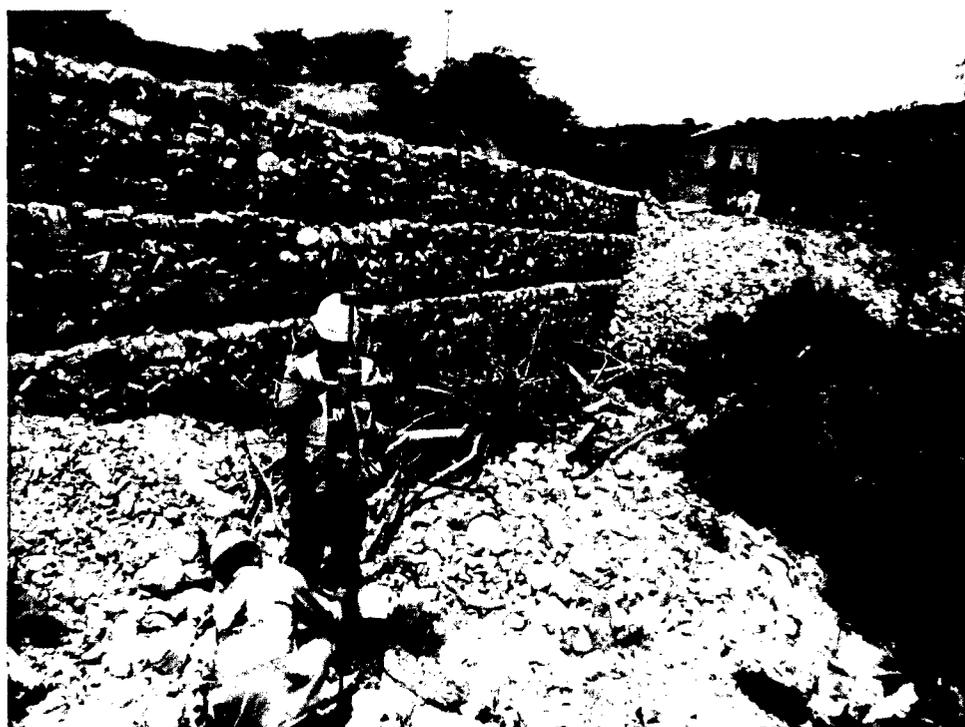
Figura 42: Verificación del esfuerzo admisible de los muros de suelo reforzado (terramesh), Km. 45+705,96 al Km. 45+735,96.
