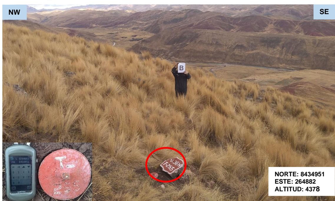
Foto 17: Ubicación de la T – 255, el círculo rojo viene a ser el centro donde se cimentará la estructura de la Torre.
