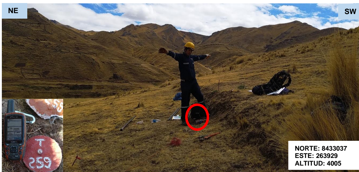
Foto 21: Ubicación de la T – 259, el círculo rojo viene a hacer el centro donde se cimentará la estructura de la Torre.
