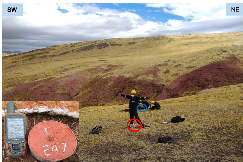
Foto 12: Ubicación de la T – 247, el círculo rojo es el centro para la torre y el círculo azul la calicata en la pata C.
