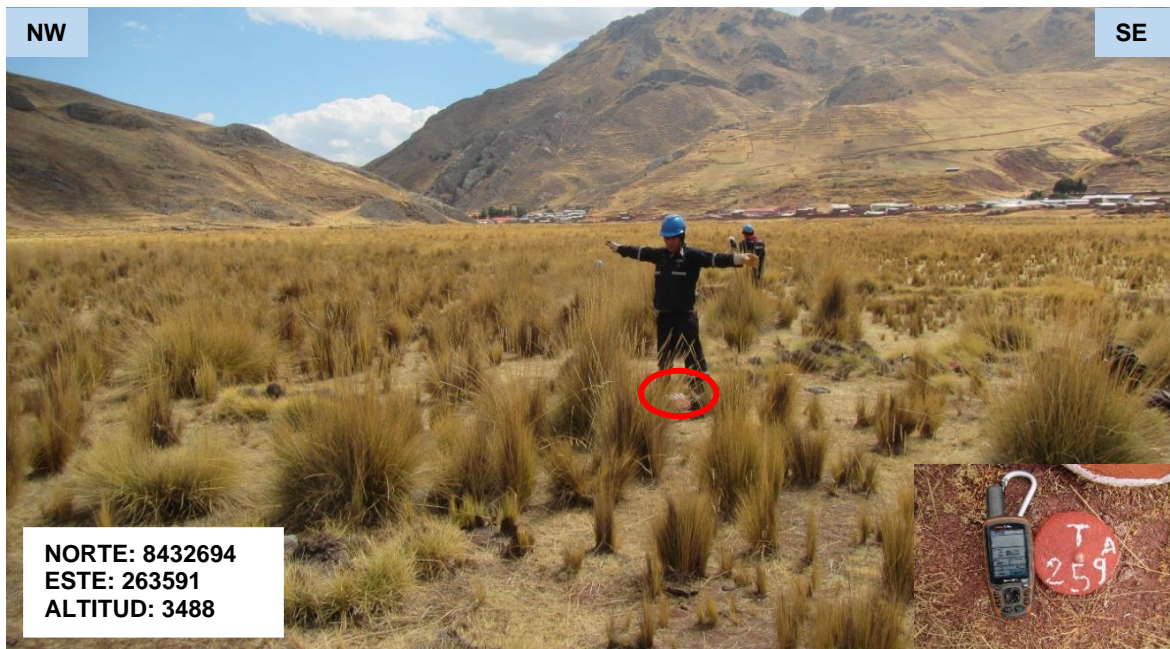
Foto 22: Ubicación de la T – 259A, el círculo rojo viene a hacer el centro donde se cimentará la estructura de la Torre.
