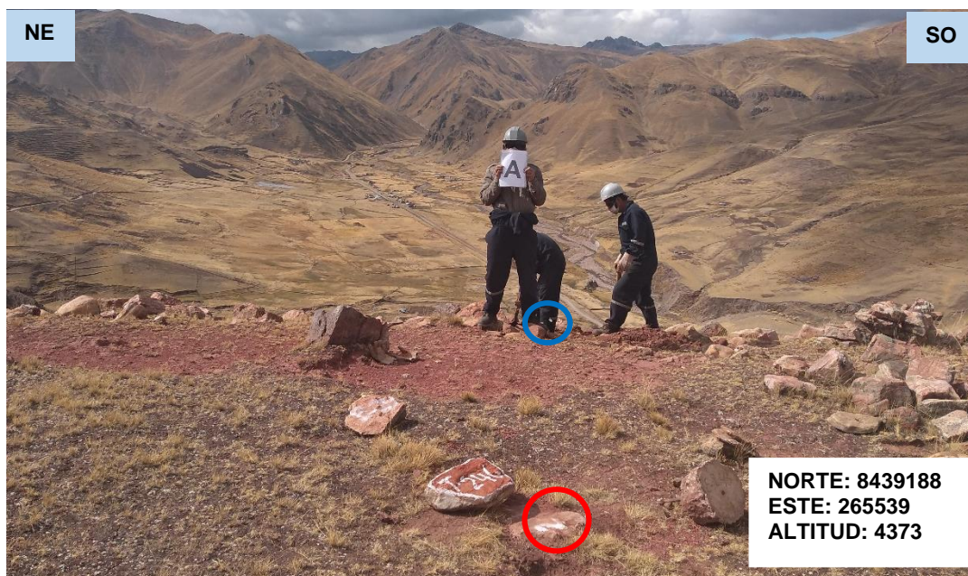
Foto 11: Ubicación de la T – 246, el círculo rojo viene a ser el centro de la torre y el círculo azul viene a ser la calicata en la pata A.
