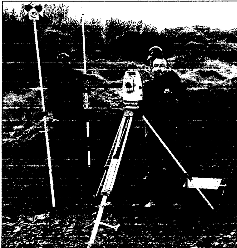
IMAGEN 3: Proyectista orientando estación total para iniciar el seccionado respectivo.
