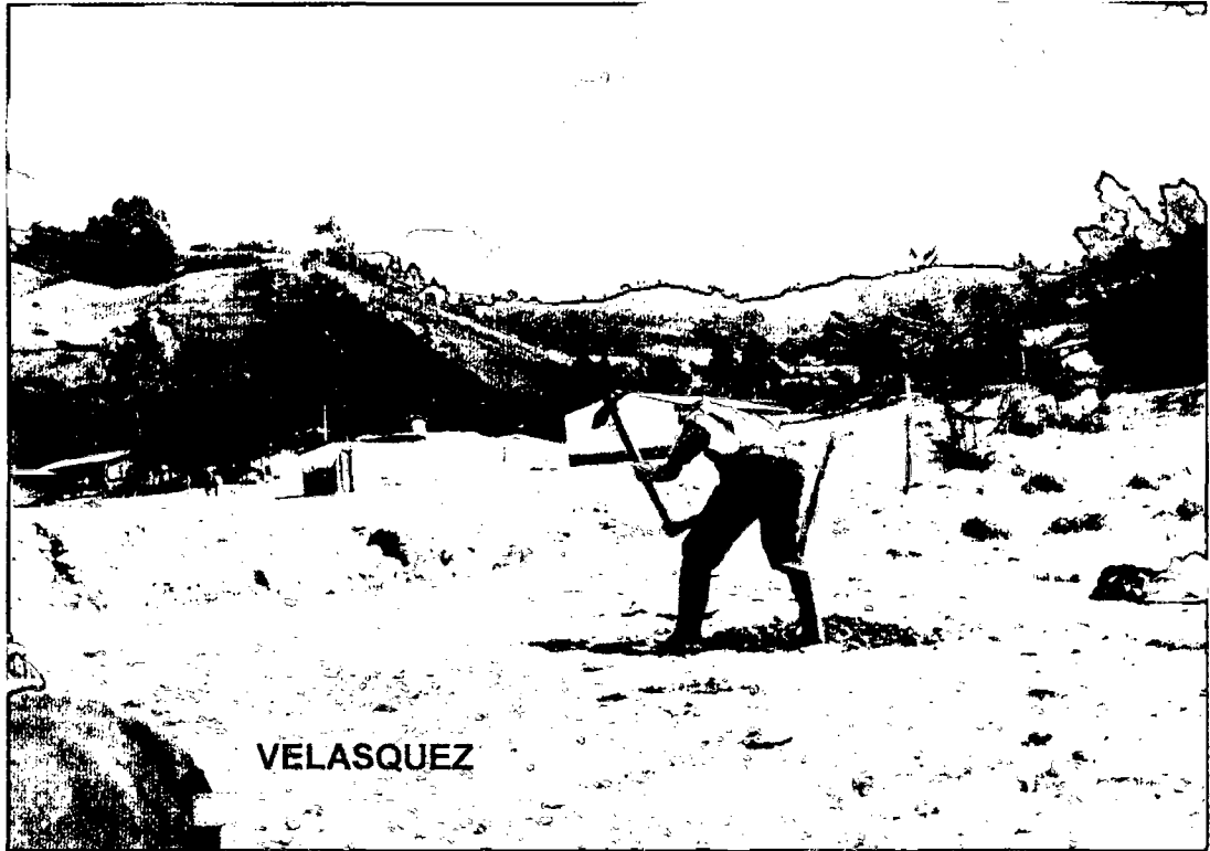
FOTO N° 01.- Inicio del Proyecto: Progresiva KM 0+000 (Velasquez), se muestra la excavación de la calicata 01
