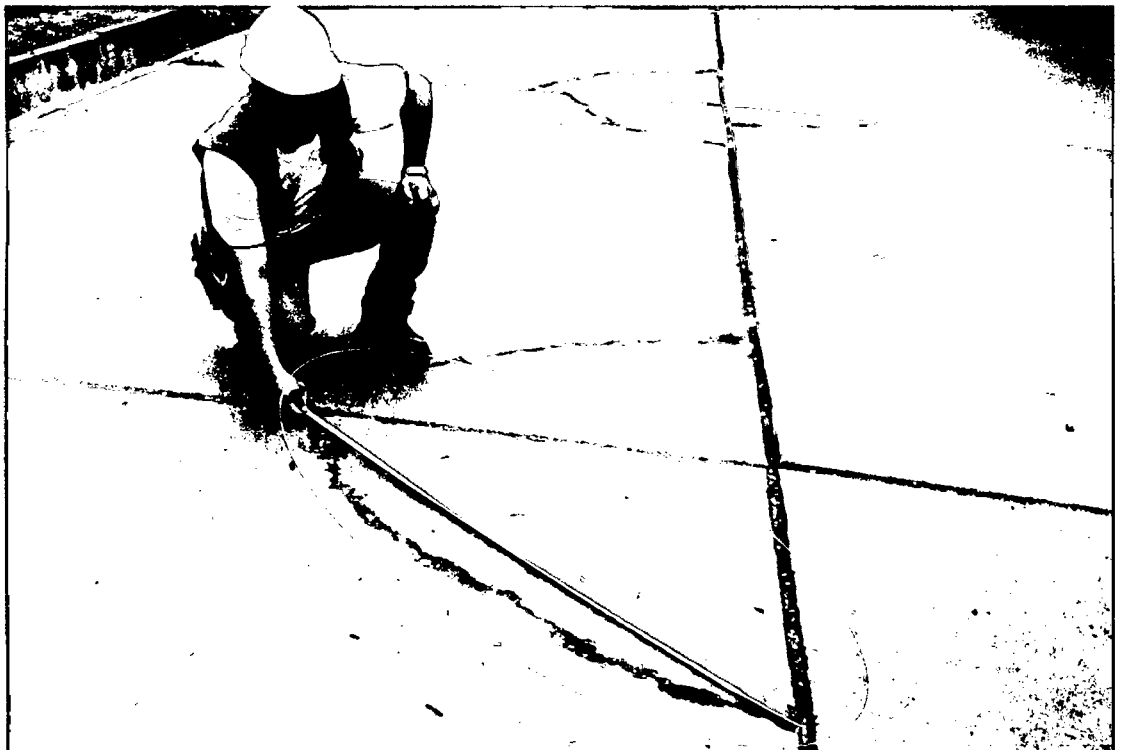
Figura 30. Inspección de la falla grieta de esquina.
