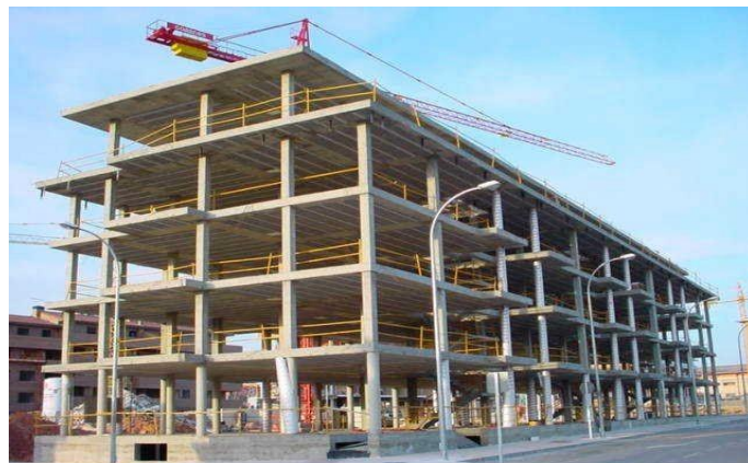
Figura 1: Estructura aporticada de concreto armado
