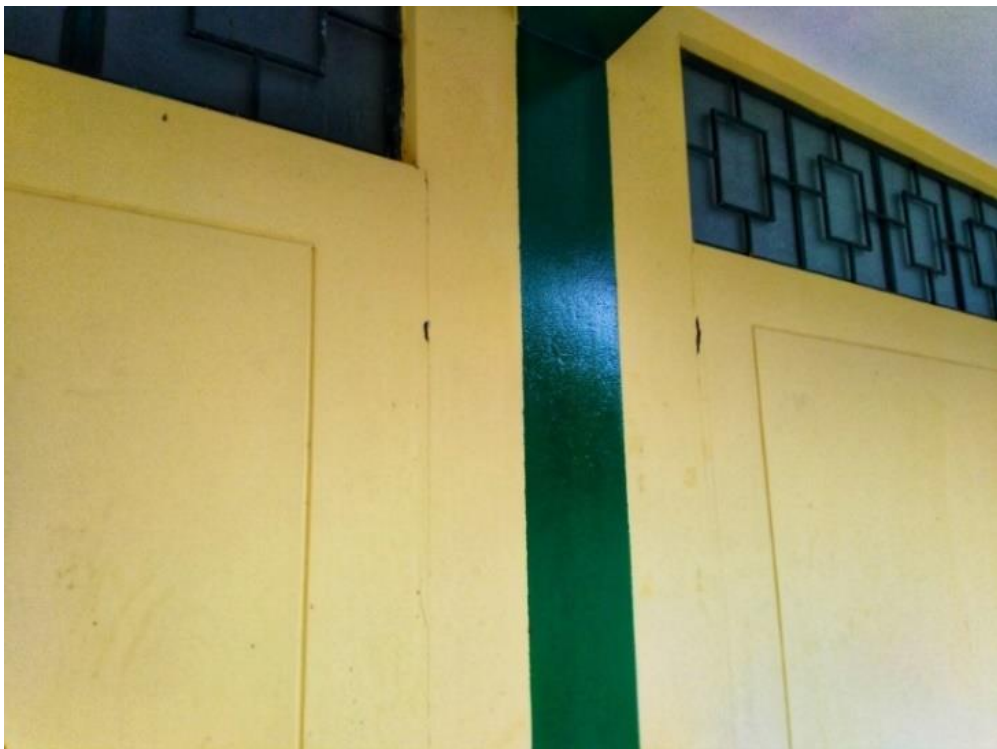
Fotografía 8. Fisura en juntas de muro con columna.
