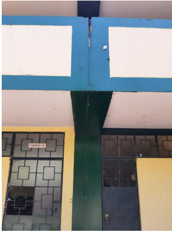
Fotografía 4. Fisura superficial en el tarrajeo de junta.
