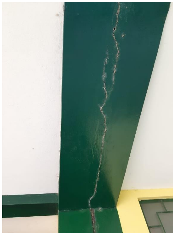
Fotografía 4. Fisura superficial en el tarrajeo de junta.
