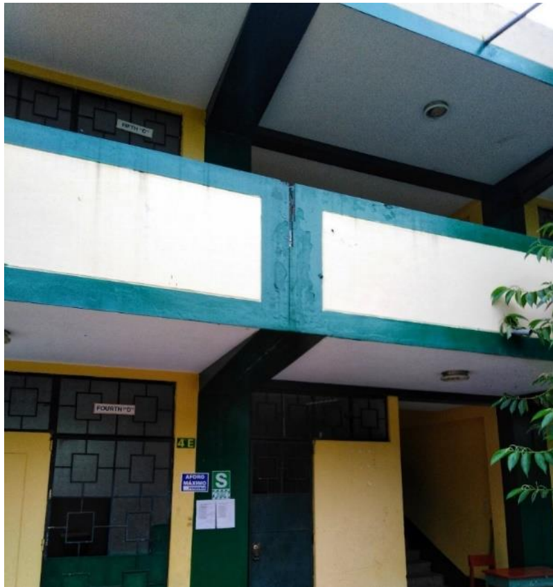
Fotografía 10. Partículas de suciedad en parapetos de azotea.
