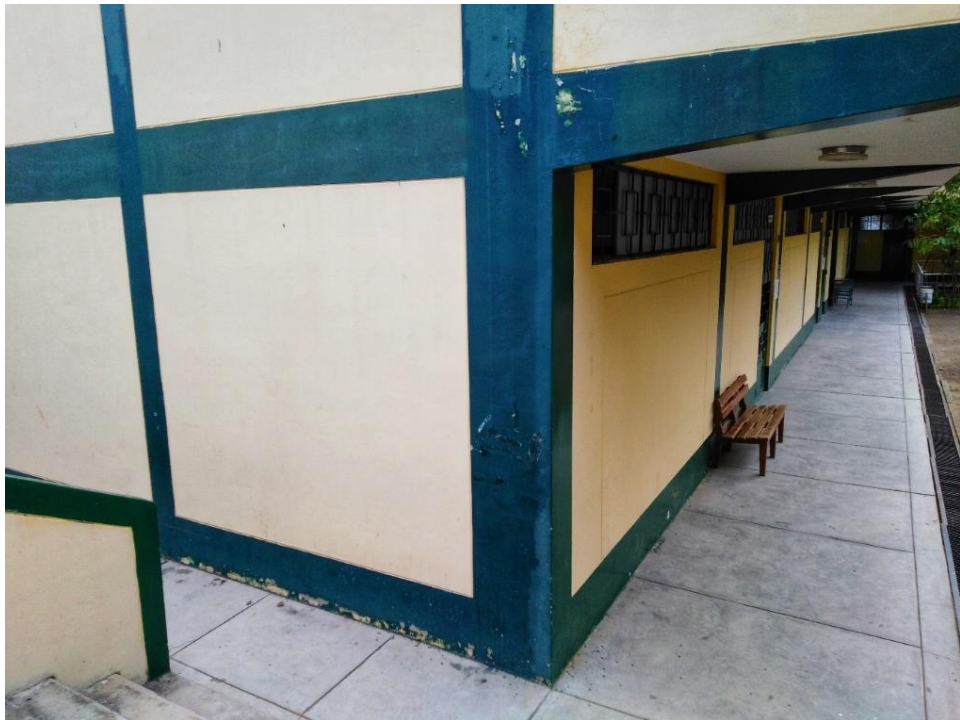
Fotografía 8. Fisura en juntas de muro con columna.
