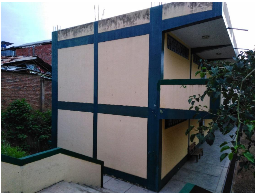
Fotografía 10. Partículas de suciedad en parapetos de azotea.
