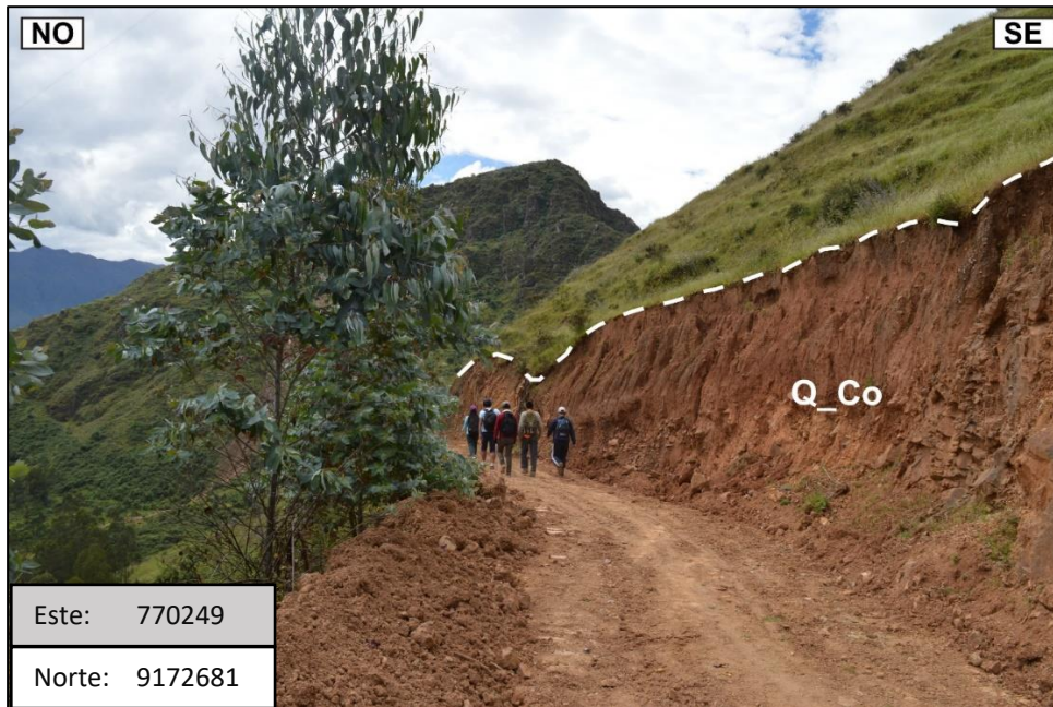
Foto 7: Depósitos Coluviales en un corte de talud, se encuentran suprayaciendo rocas de la Formación Farrat (progresiva Km 01+300).
