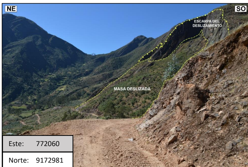
Foto 16: Deslizamiento traslacional antiguo, margen izquierdo de la carretera hacia Rambrán (progresiva Km 03+700).
