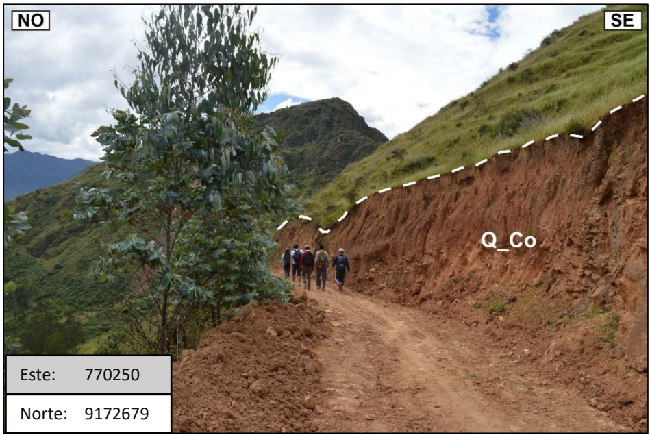
Foto 39: Talud inestable sobre un depósito Coluvial en las progresivas Km 1+280 – Km 1+330
