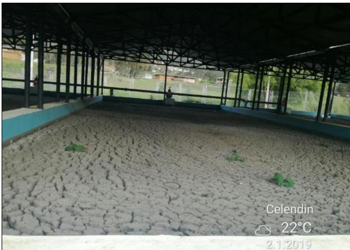
Figura 37. Lodo residual en los lechos de secado
