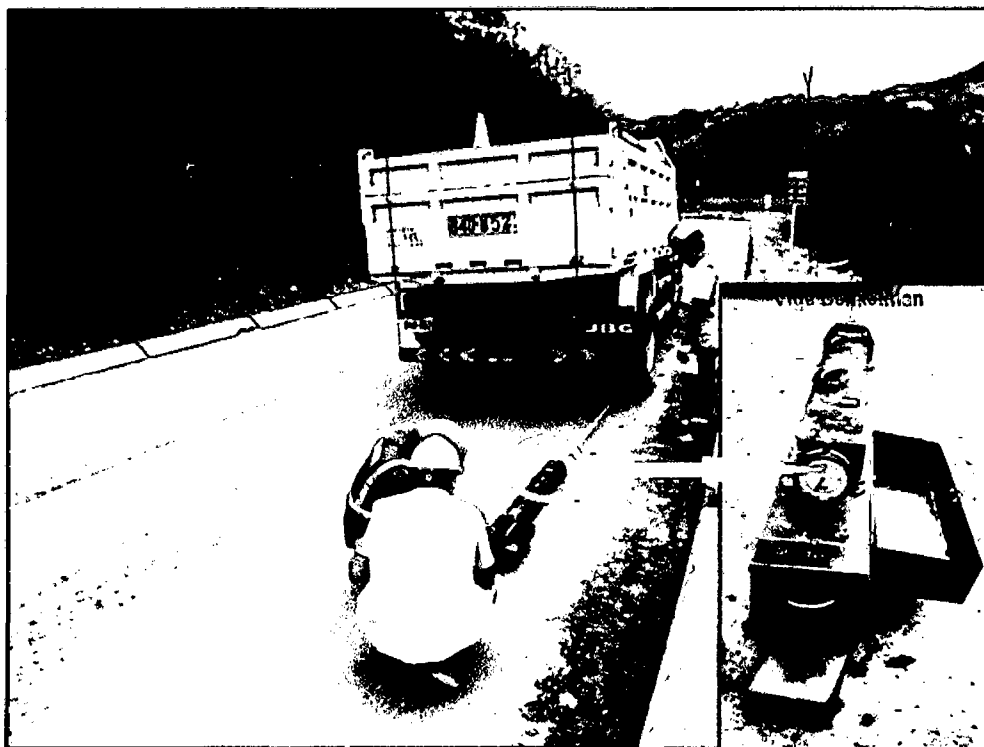
Figura 13. Colocación de la Viga Benkelman, Posición inicial y final.
