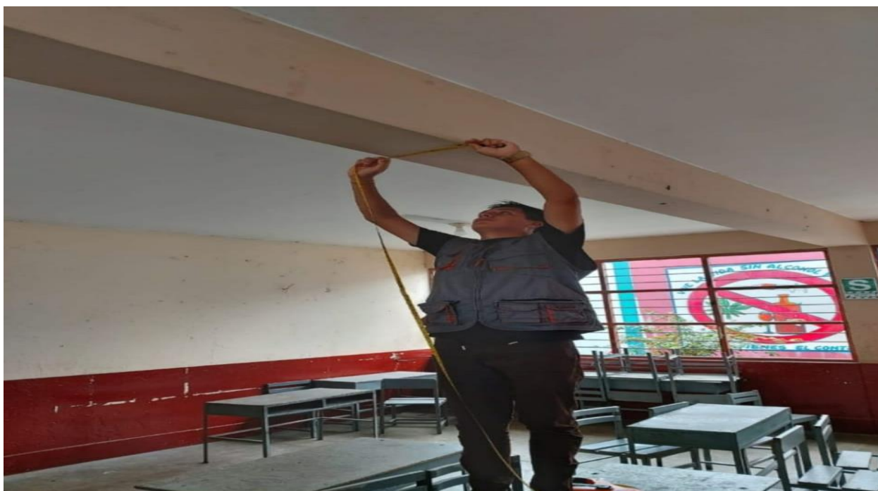
Fotografía N°04: Vista de la viga.
