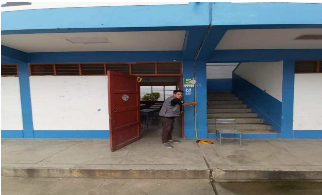
Fotografía N°03: Junta de espaciamiento entre bloques 7cm.
