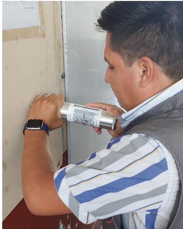
Fotografía N°05: Ensayo de Esclerometría en el muro del 1er nivel del Eje 1--1.
