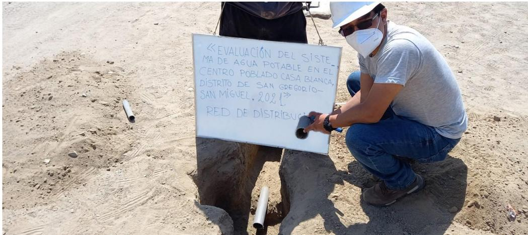
**Figura N° 38:** Evaluado el diámetro y estado de la red de distribución en las conexiones más bajas
