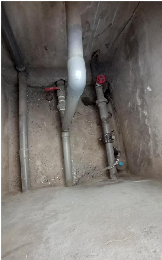
**Figura N° 32:** Instalación del piezómetro en el reservorio
