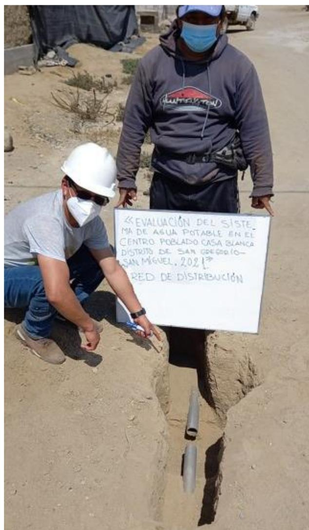
**Figura N° 37:** Evaluando el diámetro y estado de la red de distribución ramales de conexiones adicionales después de la ejecución del proyecto y alejadas
