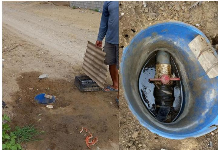
**Figura N° 25:** Válvulas de distribución con estructura de protección, no presenta candado de seguridad y presenta fugas
