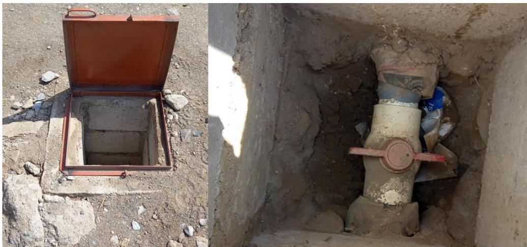
**Figura N° 26:** Tubería con obstrucción petrificada dentro del diámetro interno de la tubería, de la red de distribución
