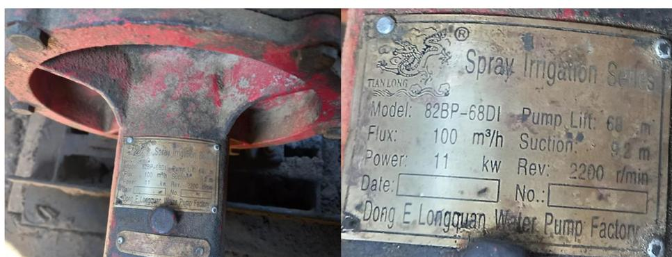
**Figura N° 20:** Vista de perfil y frontal del equipo de bombeo
