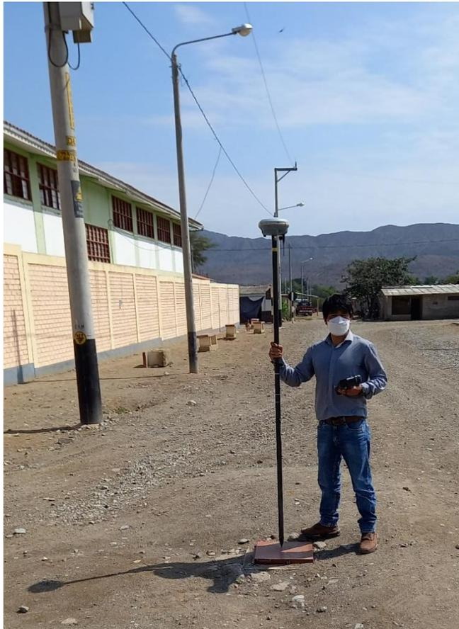
**Figura N° 45:** Levantamiento topográfico de la línea de impulsión y aducción
