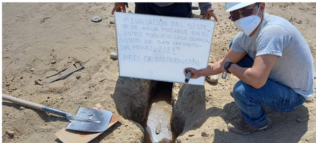
**Figura N° 39:** Evaluando el diámetro y estado de la red de distribución ramales principales antiguos
