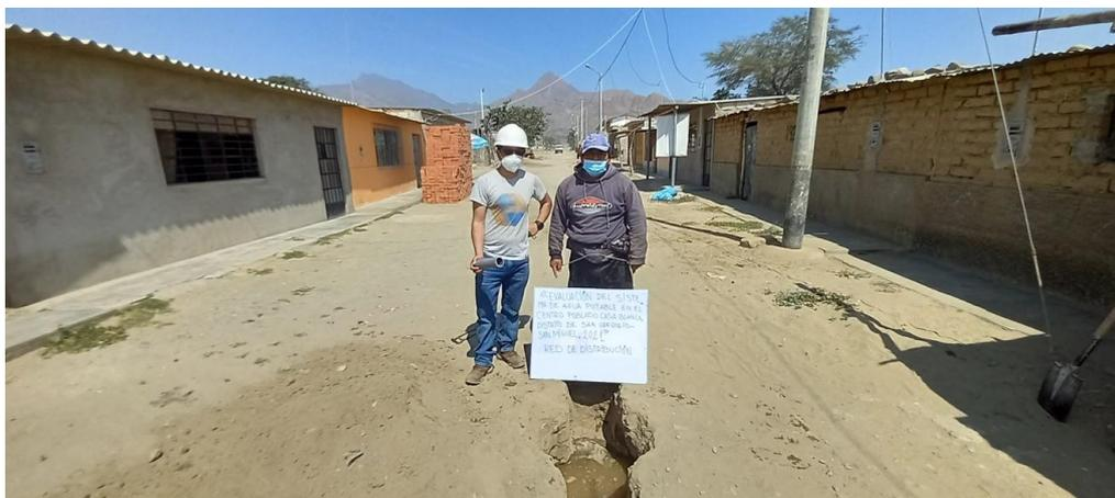
**Figura N° 40:** Tubería expuesta en red de distribución expuesta al paso de quebrada
