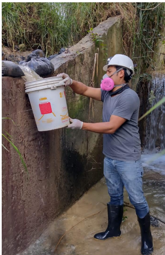
Figura 34: Aforo por el método volumétrico
