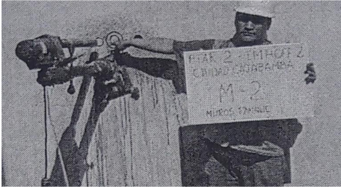
Figura 4: Extracción de segunda muestra adyacente a los puntos de ensayo de esclerometría, debido a que la muestra 01 no servirá para ensayo de compresión por estar fisurada.
