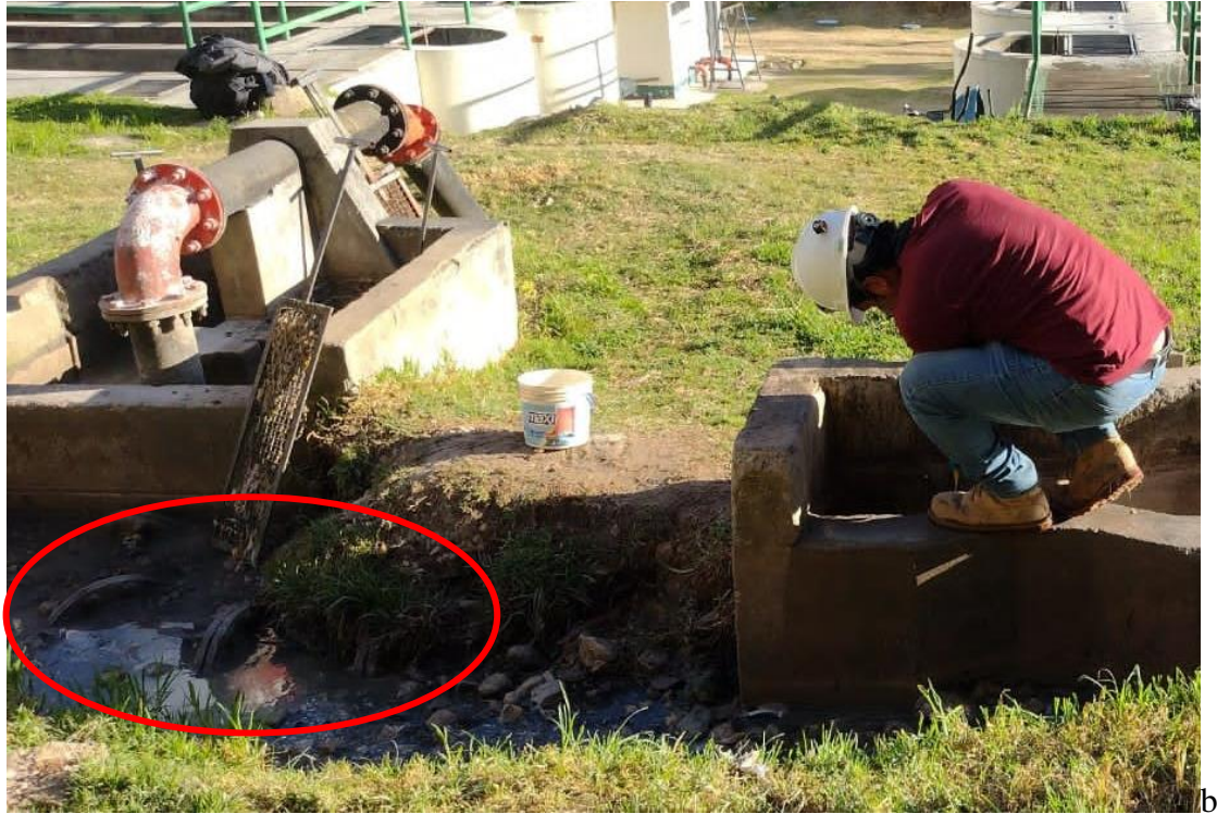
Figura 17: Tubería de conducción
