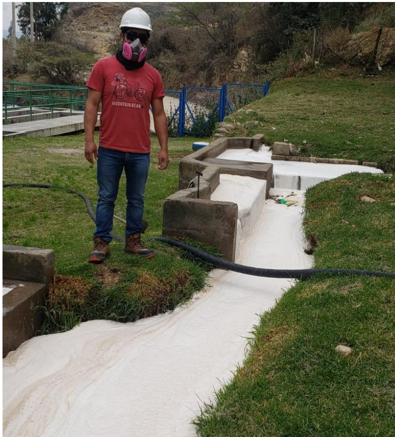
Figura 28: Tratamiento primario colapsa solo en el horario de 9am a 10am
