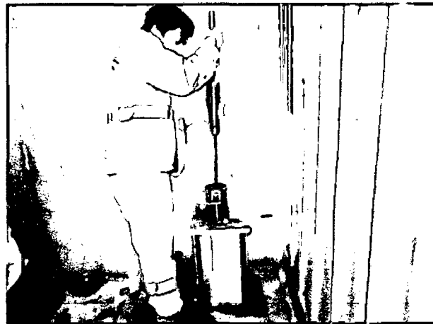
Figura 3.13: Compactación de la mezcla asfáltica
