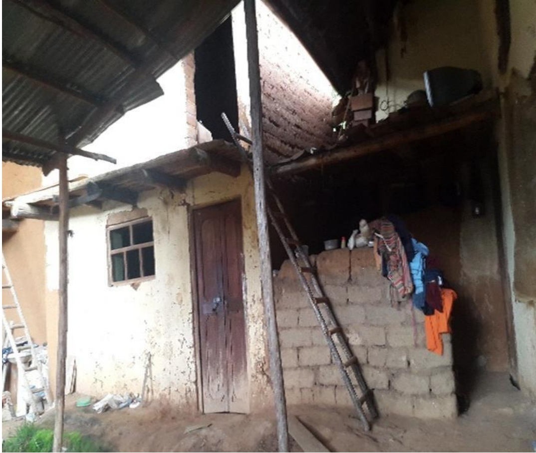
Figura 4 Parte frontal de una vivienda del caserío Corisorgona
