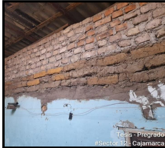
Combinación de muros: ladrillo y adobe
