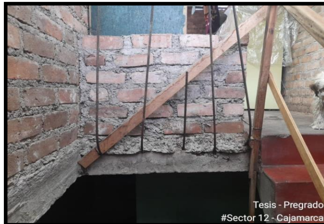
Aceros expuestos en tercer nivel de la casa
