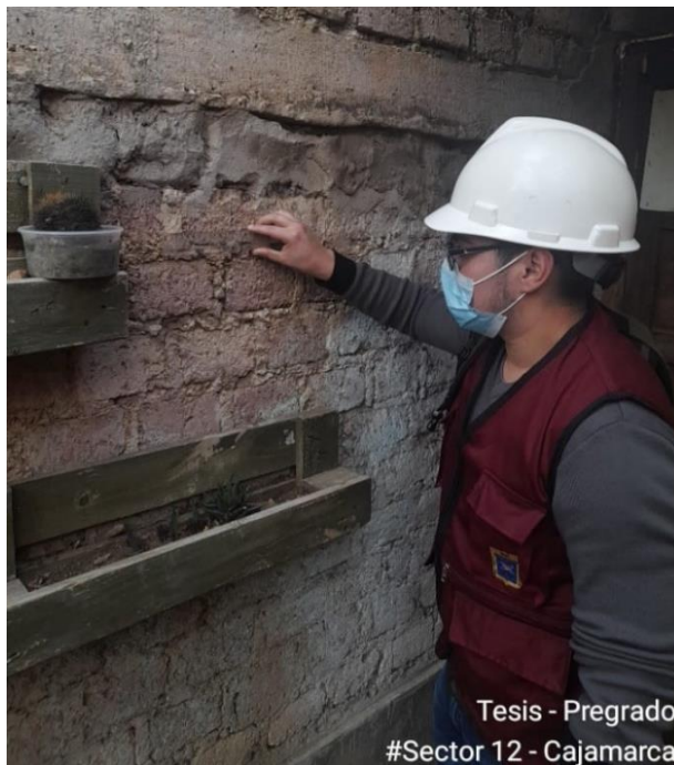
Fotografía N°6: Medición de juntas en muro
