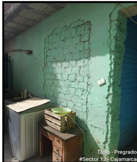
Muro portante de vivienda
