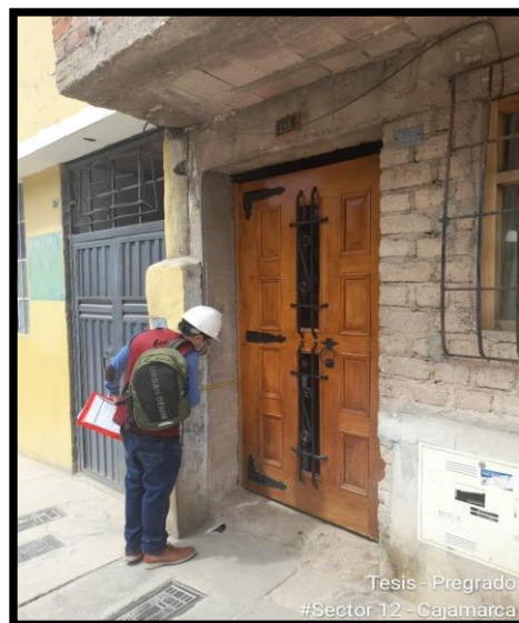
Medición de columnas externas
