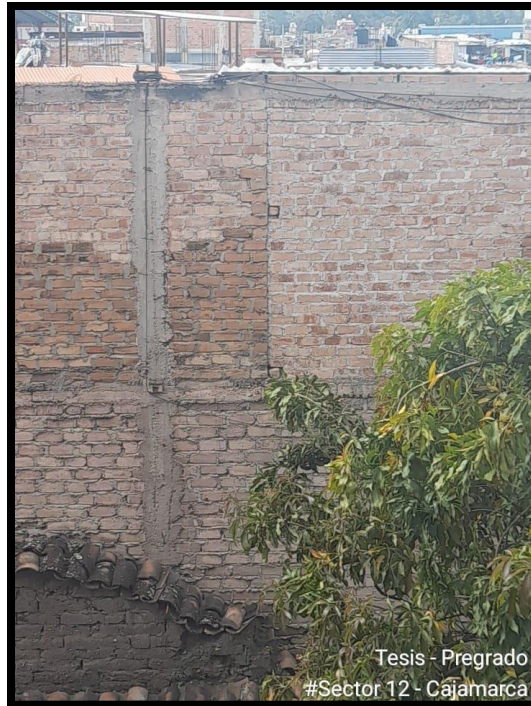
Fotografía N°7: Ladrillo con diferentes grados de cocción
