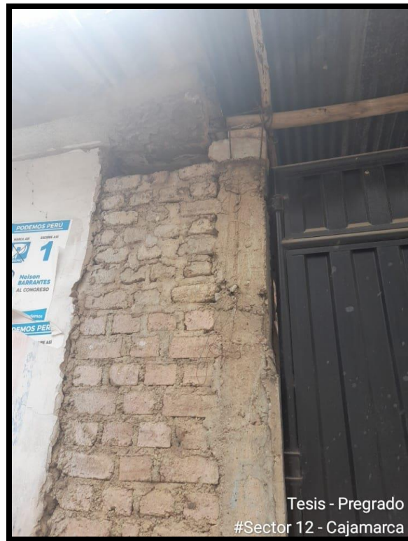
Fotografía N°9: Vivienda con techo de calamina
