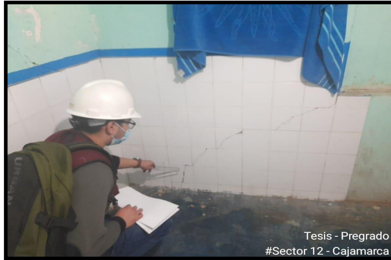
Falla en muro portante de baño
