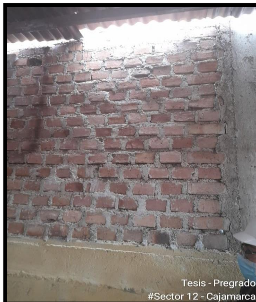
Muro portante en vivienda
