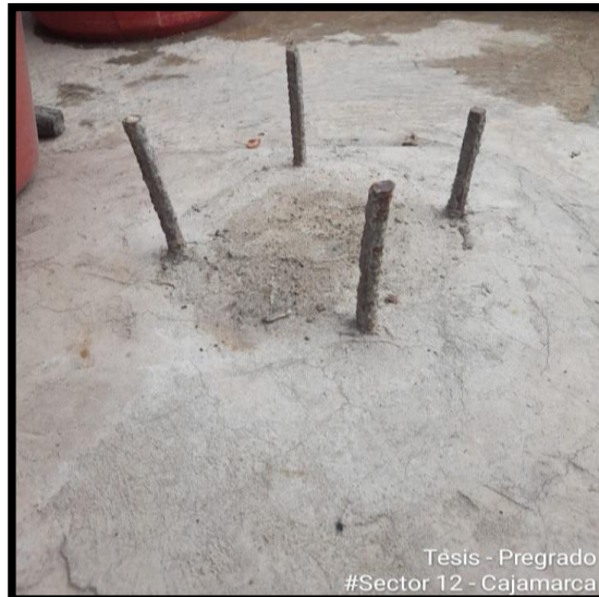
Acero de columna expuesto en losa
