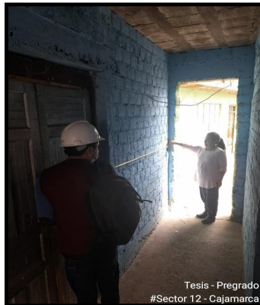
Medición de muros
