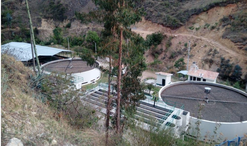
Vista panorámica de la PTAR Cajabamba
