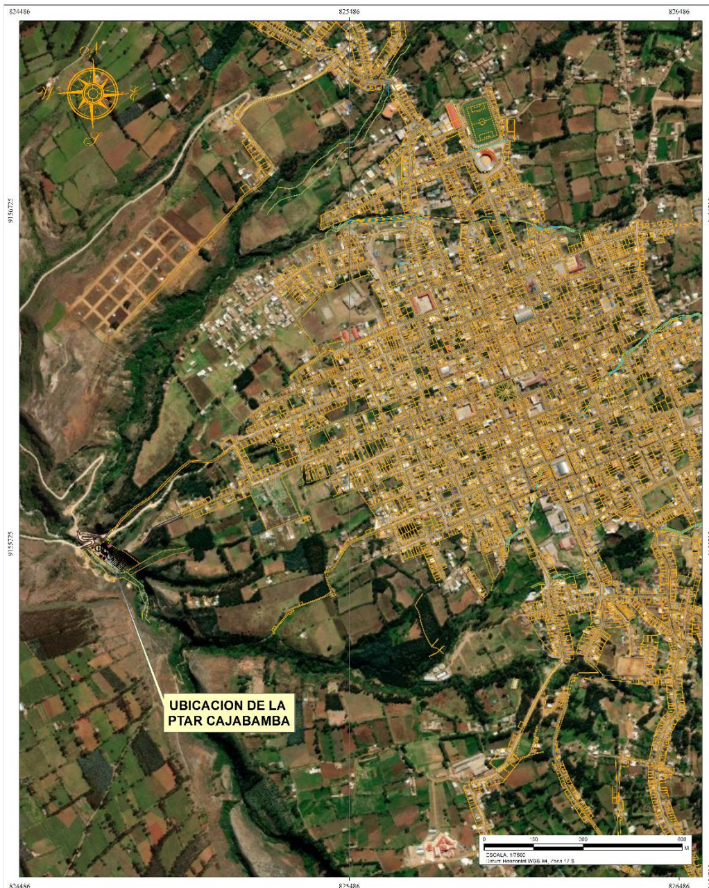
Figura 9. Ubicación de la planta de tratamiento de aguas residuales de Cajabamba
