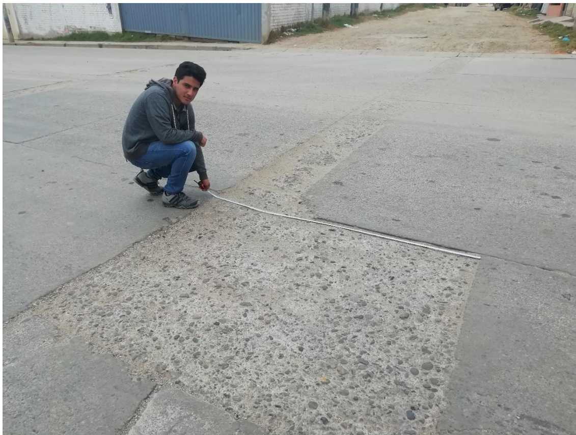
Foto N° 8: Parcheo grande, progresiva 1+650.00. Intersección jr. Barrantes Lingán
