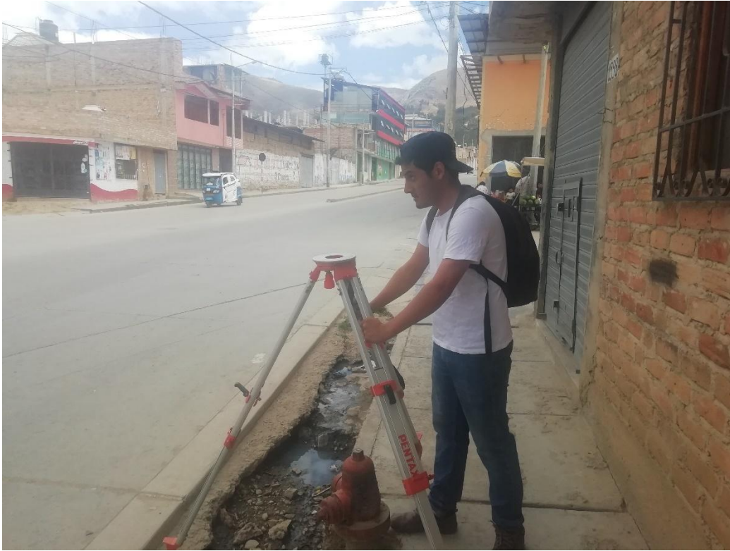
Foto N° 1: Levantamiento topográfico de la Av. Héroes del Cenepa. Progresiva 1+530.00m
