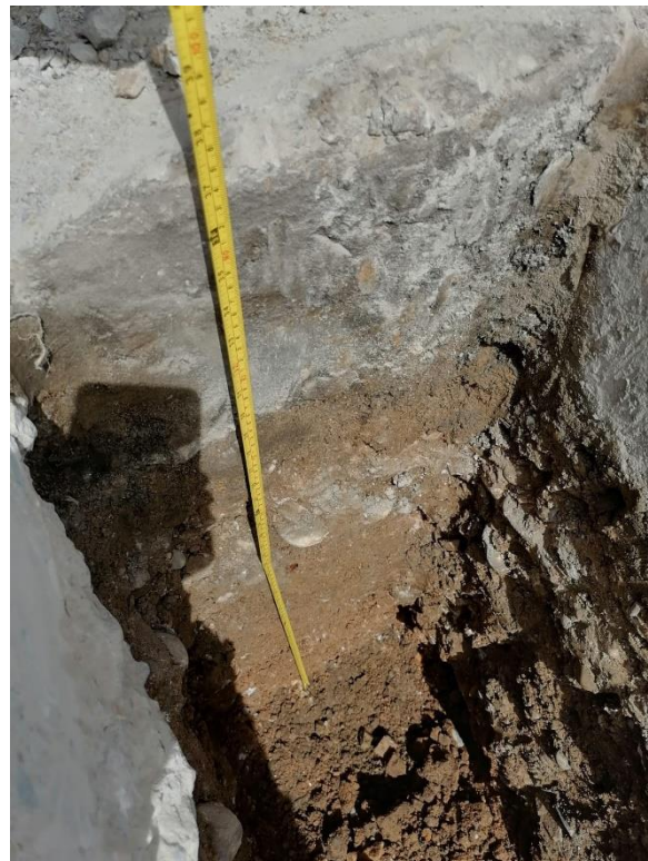
Foto N° 16: Estructura del pavimento. Progresiva 2+242.00m
