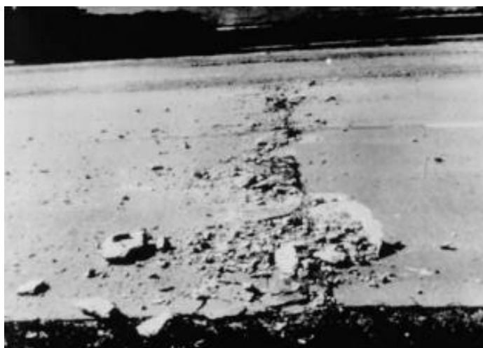
Imagen N° 1. Blow up/Buckling
