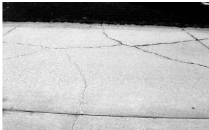
Imagen N° 3. Losa dividida
