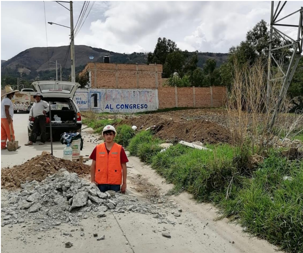
Foto N° 15: Calicata exploratoria. Progresiva 2+242.00m
