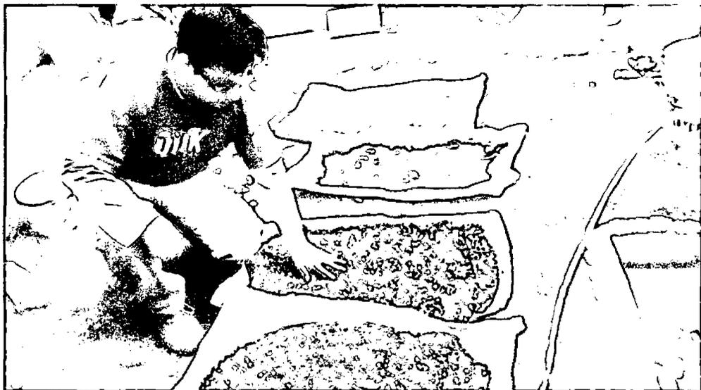
Foto 2. Secado al aire del agregado lavado
